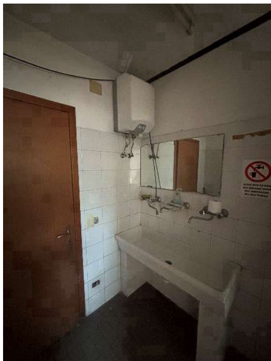
ANTIBAGNO WC CAPANNONE
