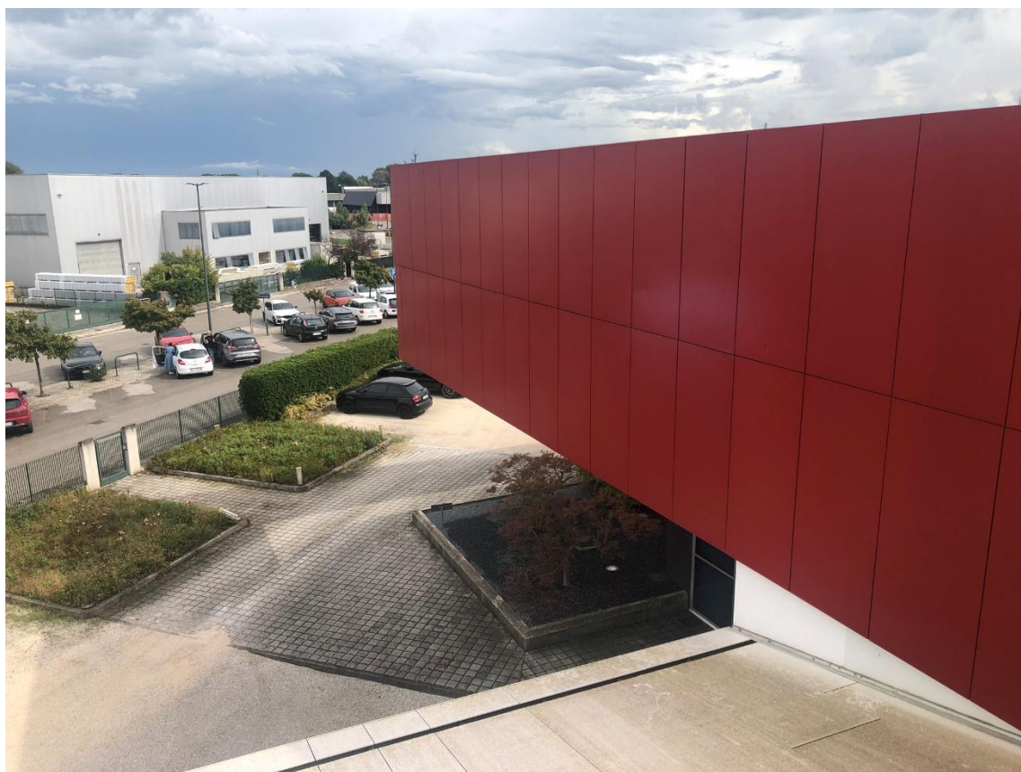
Figura 75 – Cortile lato nord
