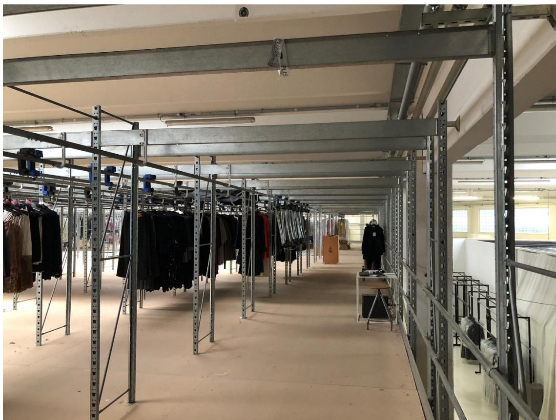
Figura 47 – Magazzino soppalcato (I piano)
