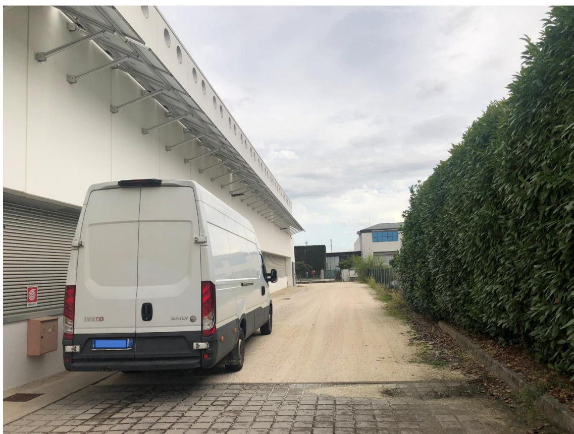
Figura 82 – Impianto fotovoltaico su lato sud
