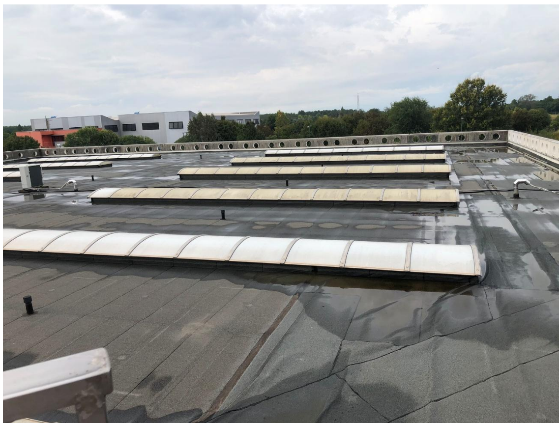
Figura 16 – Copertura della porzione ad uso produttivo
