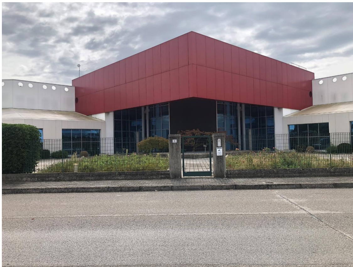
Figura 6 – Particolare facciata nord
