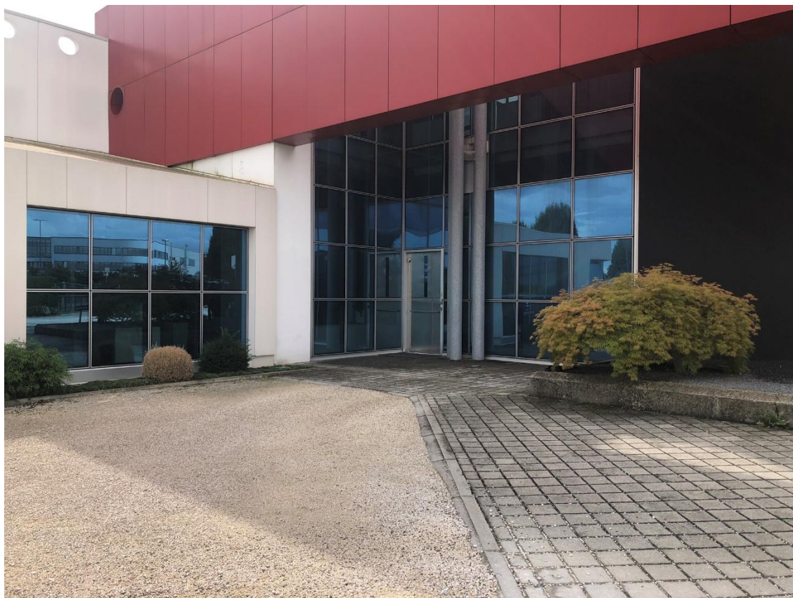
Figura 56 – Ingresso uffici (facciata nord)
