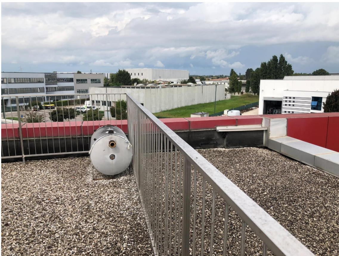
Figura 17 – Copertura della porzione a uso uffici costruita nel 2000
