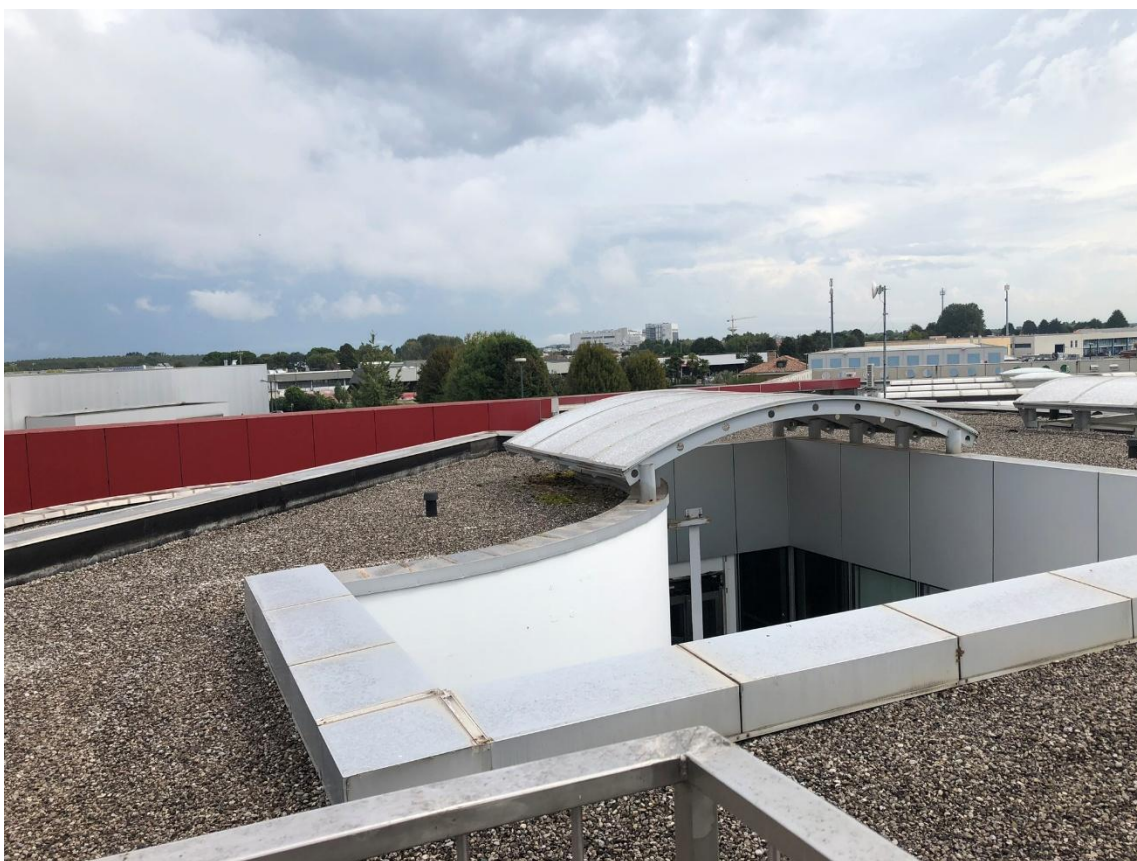
Figura 18 – Copertura porzione ad uso uffici costruita nel 2000
