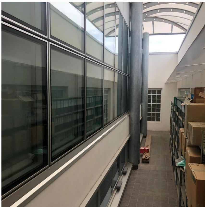
Figura 70 – Cavedio al primo piano
