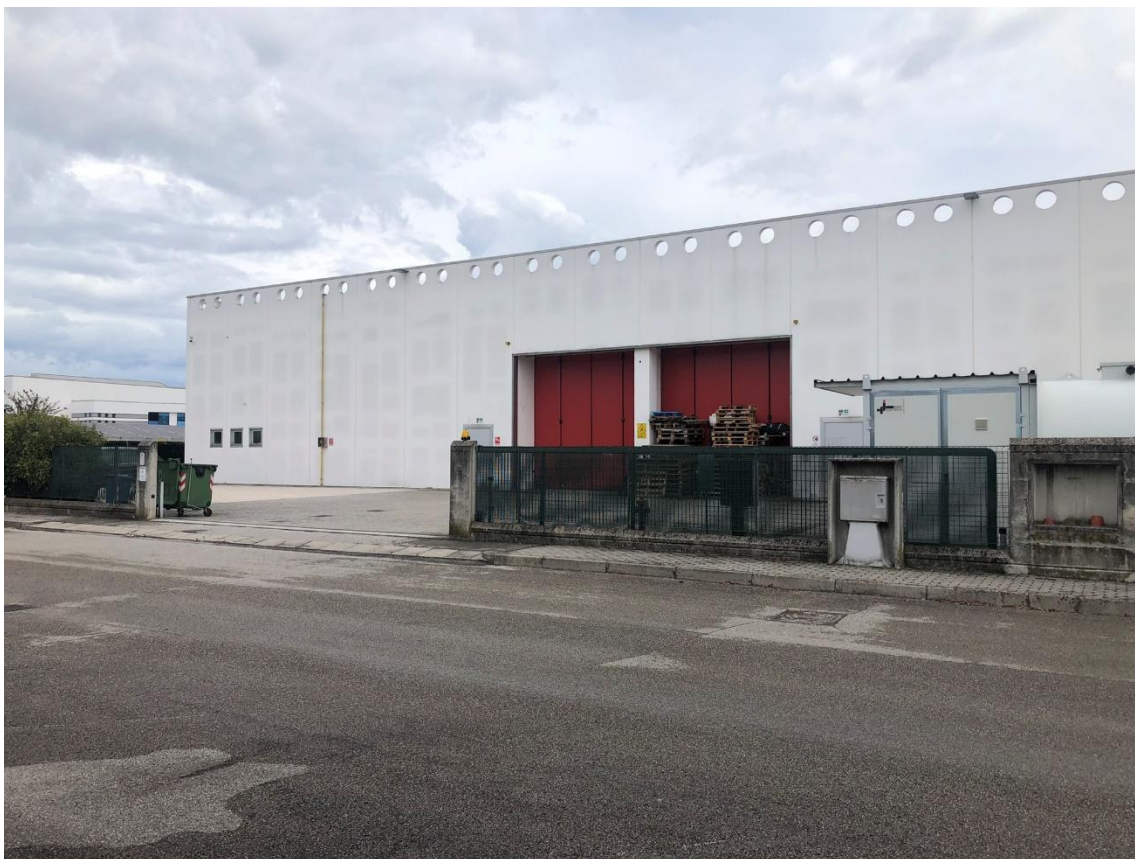
Figura 78 – Portone carraio sul lato ovest
