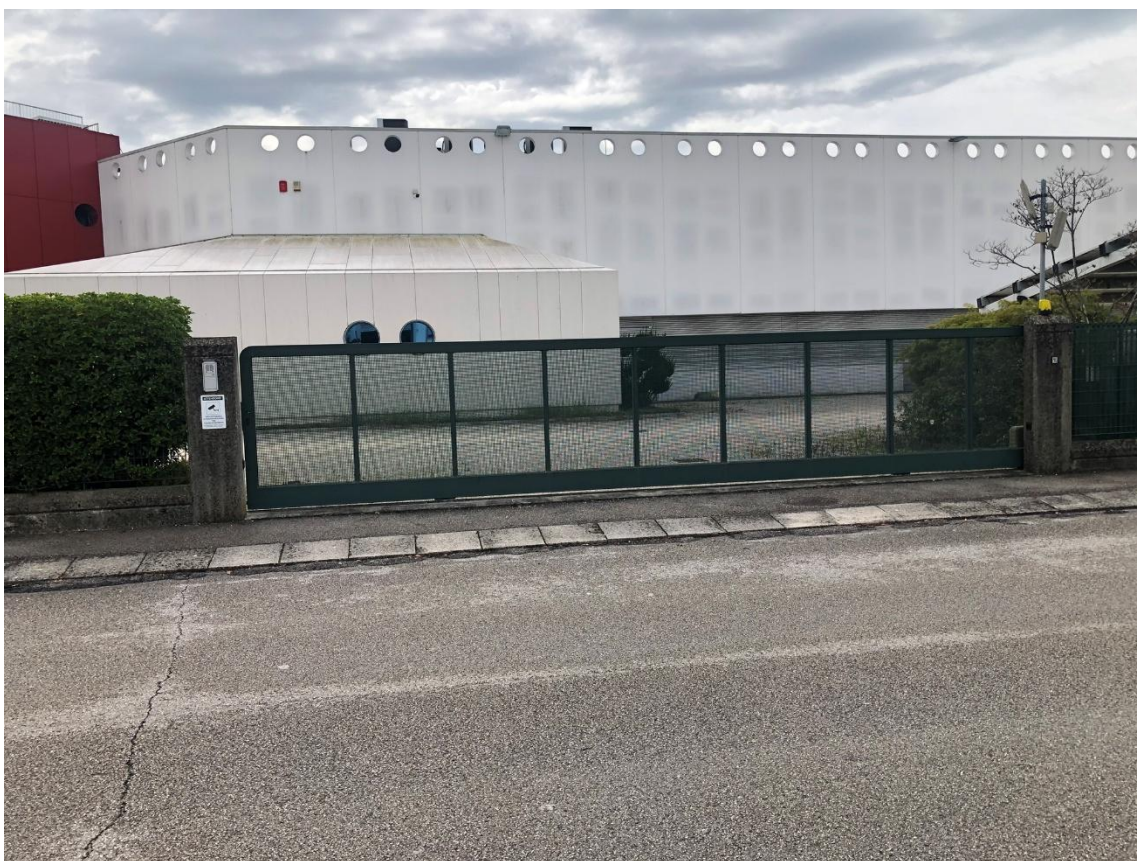
Figura 77 – Portone carraio su via Ghebo
