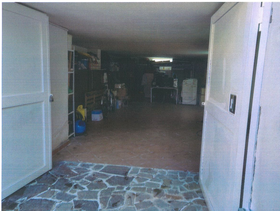
Foto 16 – Deposito al piano seminterrato
