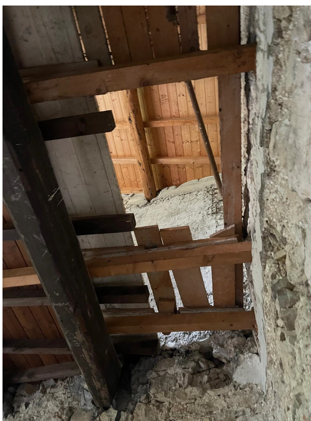
Foto n°14: Particolare del solaio di copertura visto dall'asola del solaio del piano secondo in mancanza della scala di accesso ( C.F. fg 303 part 71/2 )
