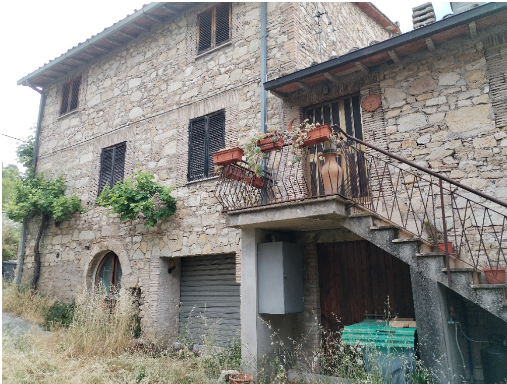
Foto n° 3: Fabbricato a confine con le U.I. oggetto di stima
