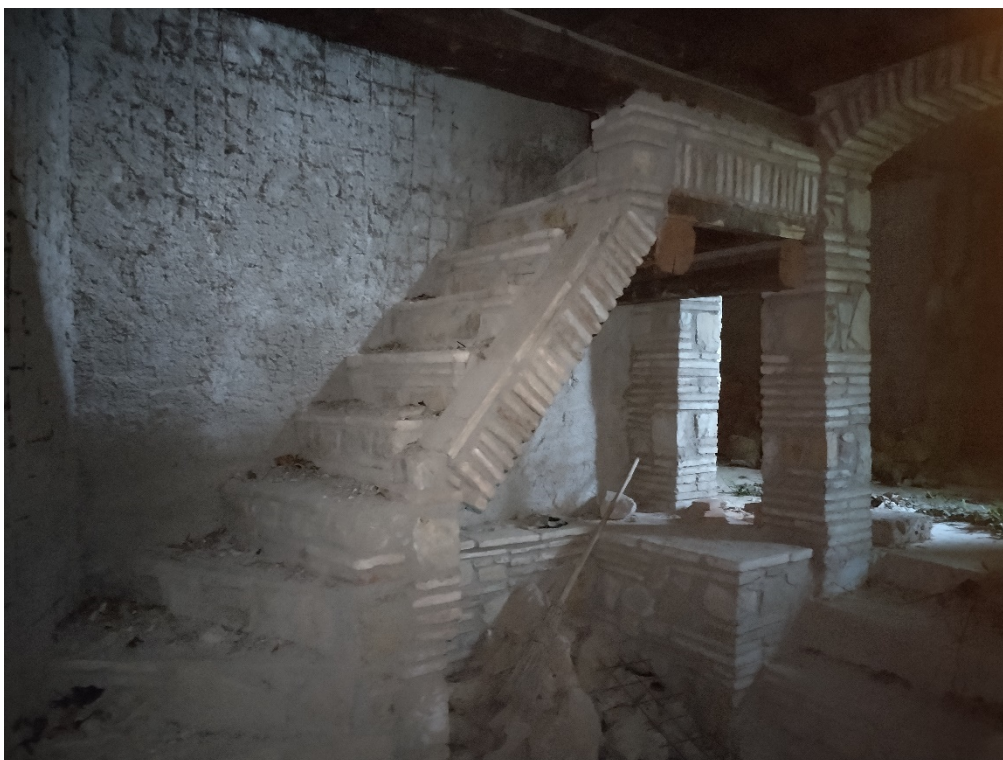
Foto n°10:particolare della scala in muratura posta nel locale ex stalla al piano terra ( C.F. fg 303 part 71/1 )
