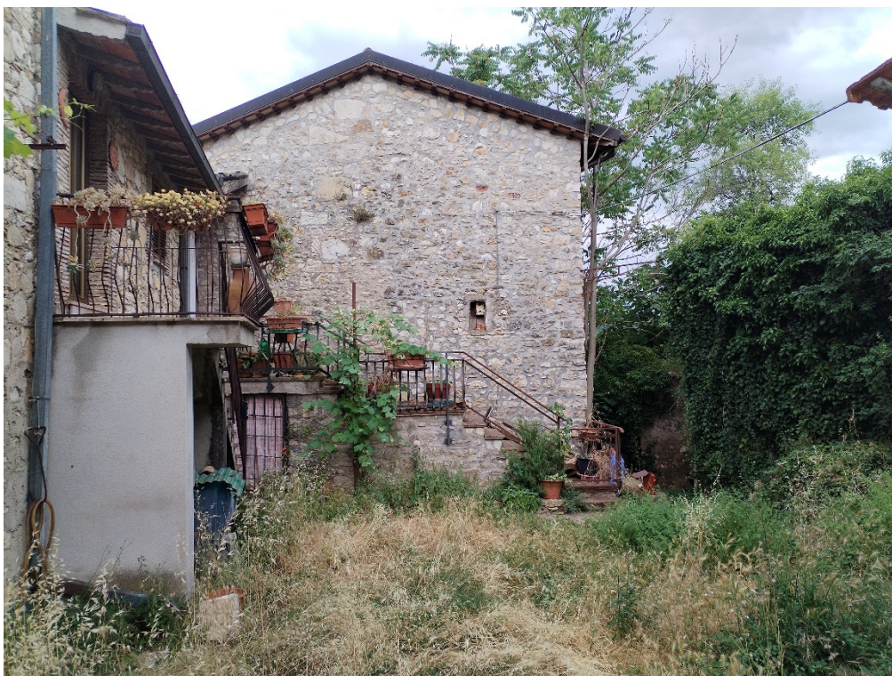
Foto n°5: Prospetto Nord del fabbricato oggetto di stima
