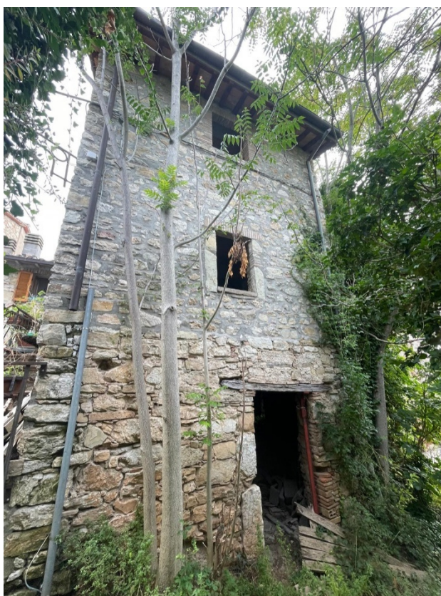
Foto n°6: Prospetto Ovest del fabbricato oggetto di stima
