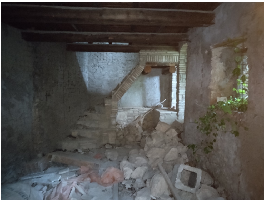
Foto n°9: locale ex stalla al piano terra ( C.F. fg 303 part 71/1 )
