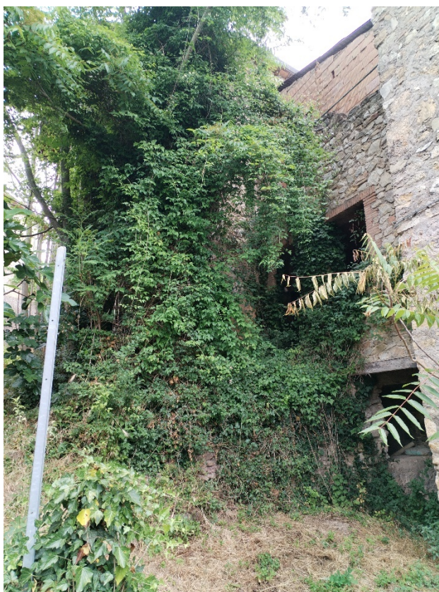
Foto n°8: Prospetto Ovest del fabbricato oggetto di stima Foto n° 7:Prospetto Sud del fabbricato oggetto di stima ( si notano varie specie infestanti arbustive ed arboree )
