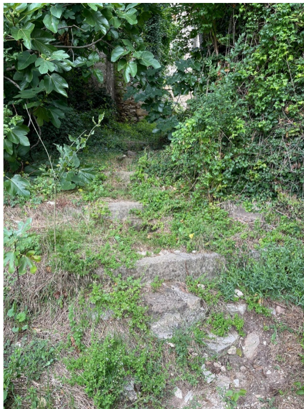
Foto n°4: Zona di accesso al fabbricato infestato da varie specie erbacee
