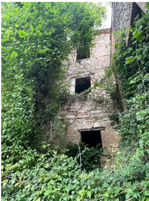
Foto n° 7:Prospetto Sud del fabbricato oggetto di stima ( si notano varie specie infestanti arbustive ed arboree )
