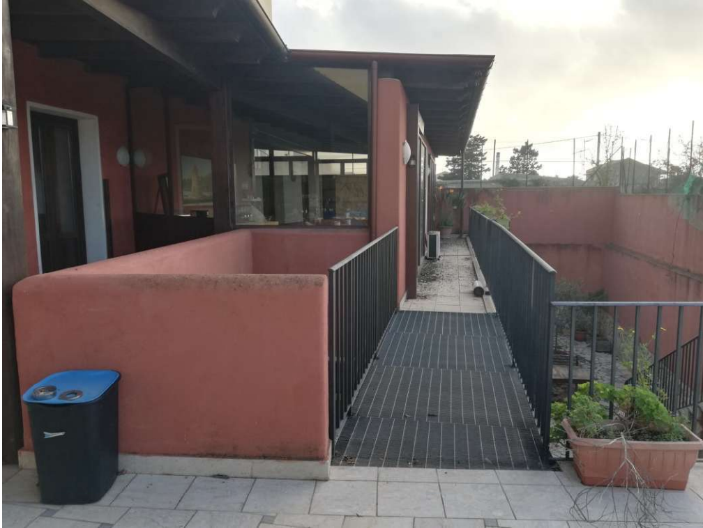
FOTO 5 - BENE 1- VISTA ESTERNA DALLA CORTE INTERNA
