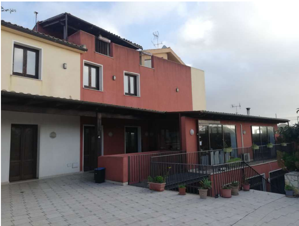
FOTO 4 - BENE 1- VISTA ESTERNA DALLA CORTE INTERNA
