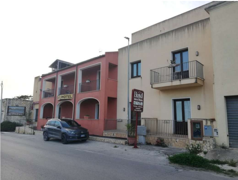
FOTO 2 - BENE 1- VISTA ESTERNA DALLA STRADA DI ACCESSO
