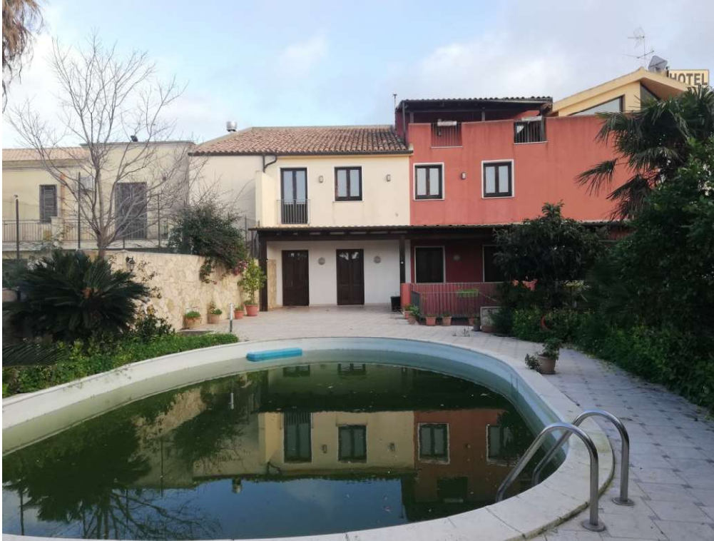
FOTO 3- BENE 1- VISTA ESTERNA DALLA CORTE INTERNA
