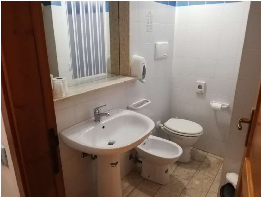
FOTO 12 - BENE 1- VISTA INTERNA DE SERVIZIO IGIENICO DELLA CAMERA TIPO
