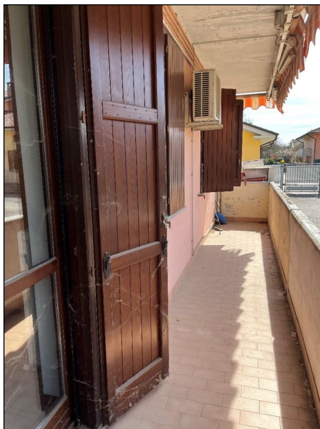
Foto n.20 – Balcone a servizio della cucina
