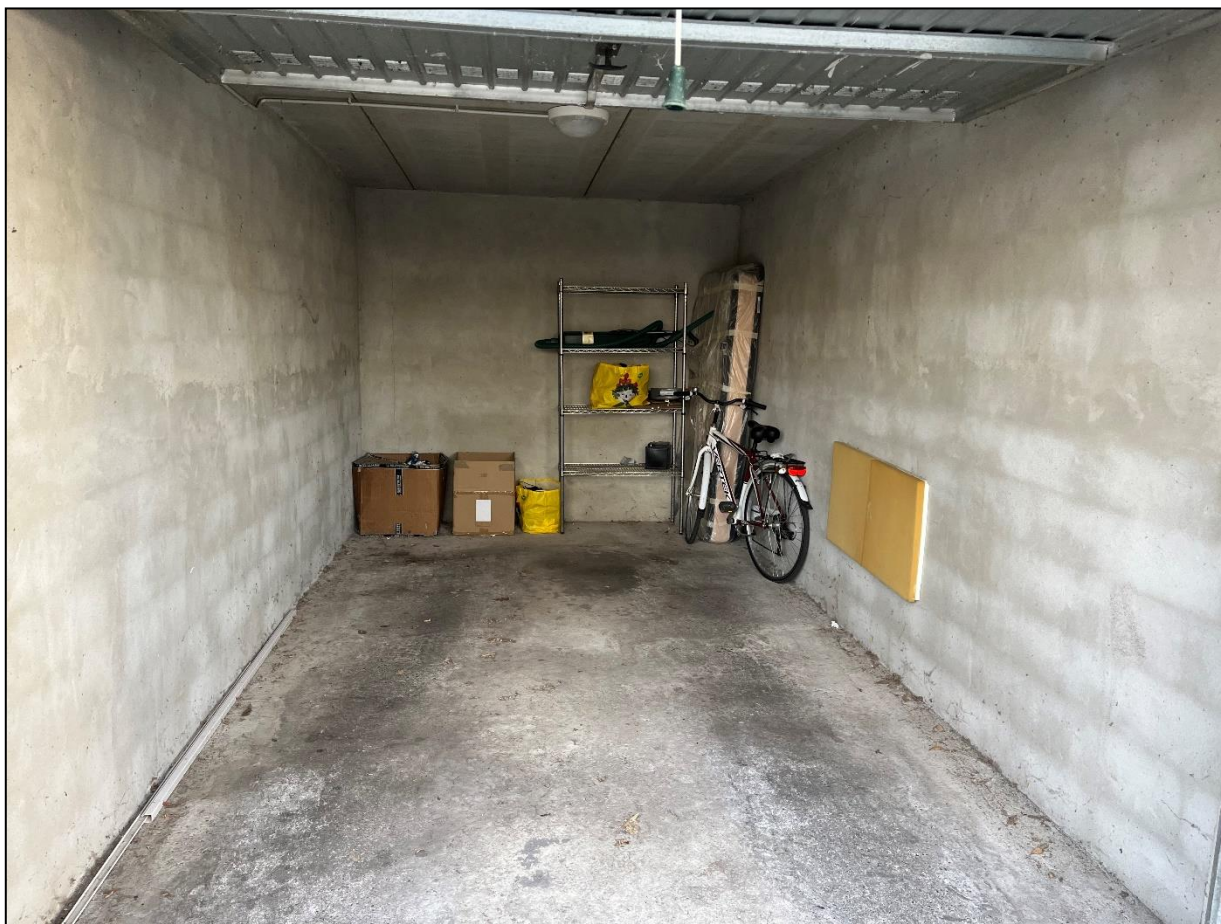
Foto n. 3 – vista interna del Box
