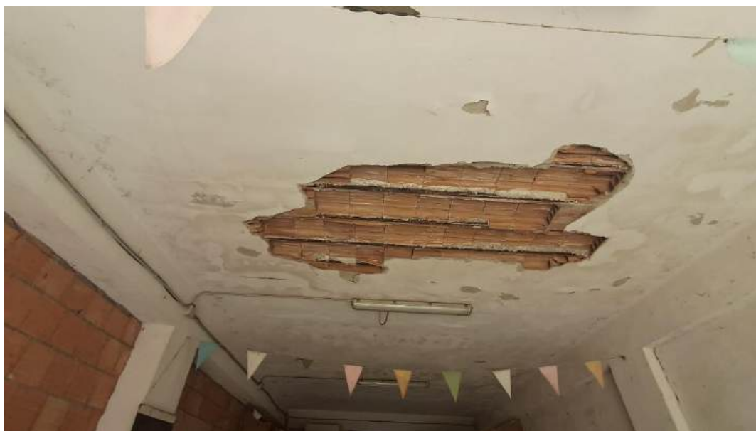
Foto 9: Catasto Fabbricati di Rizziconi, foglio 19, particella 233 sub 9 – autorimessa, distacchi di intonaco e parti di tavelle.
