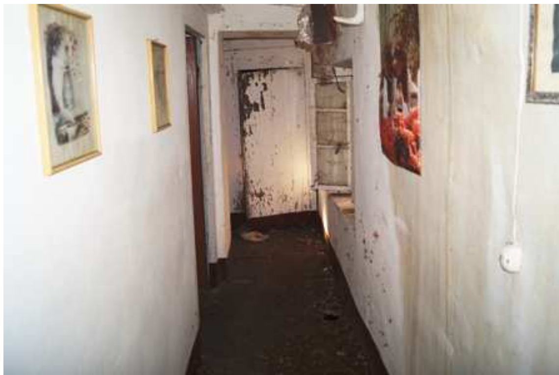
corridoio (piano primo)
