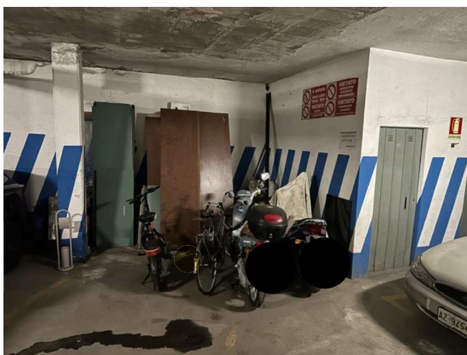
RIPRESA FOTOGRAFICA 17 EFFETTUATA DAL C.T.U. – POSTO AUTO PIANO INTERRATO – SUB. 16
