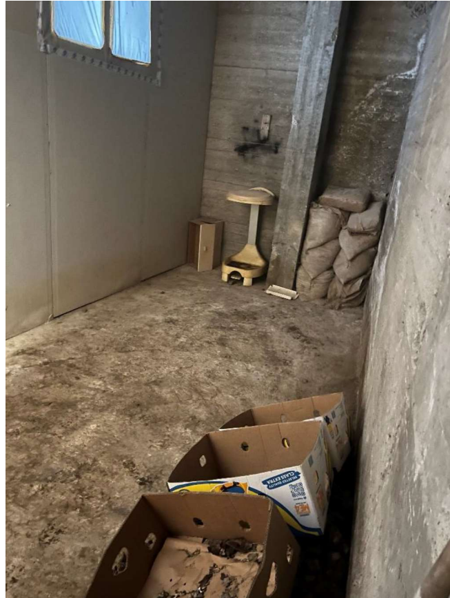
Foto 4: Interno Piano Terra
