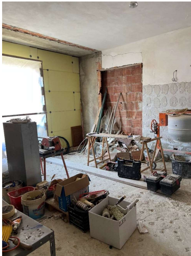
Foto 8: Zona in costruzione piano primo
