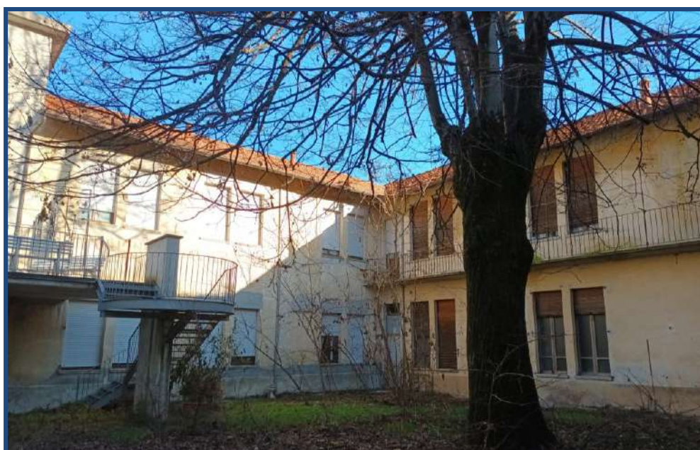
foto 07 - Maniche Nord-Est e Sud-Est vista cortile interno
