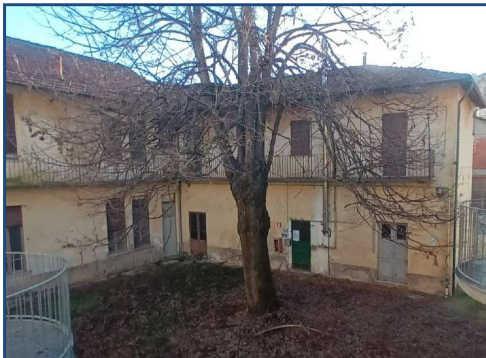
foto 08 - Maniche Sud-Est e Sud-Ovest vista cortile interno
