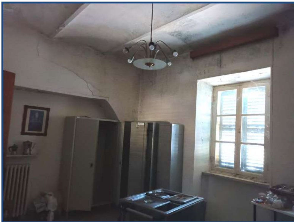
foto 38 - P.1. - Manica Sud-Ovest loc. sgombero
