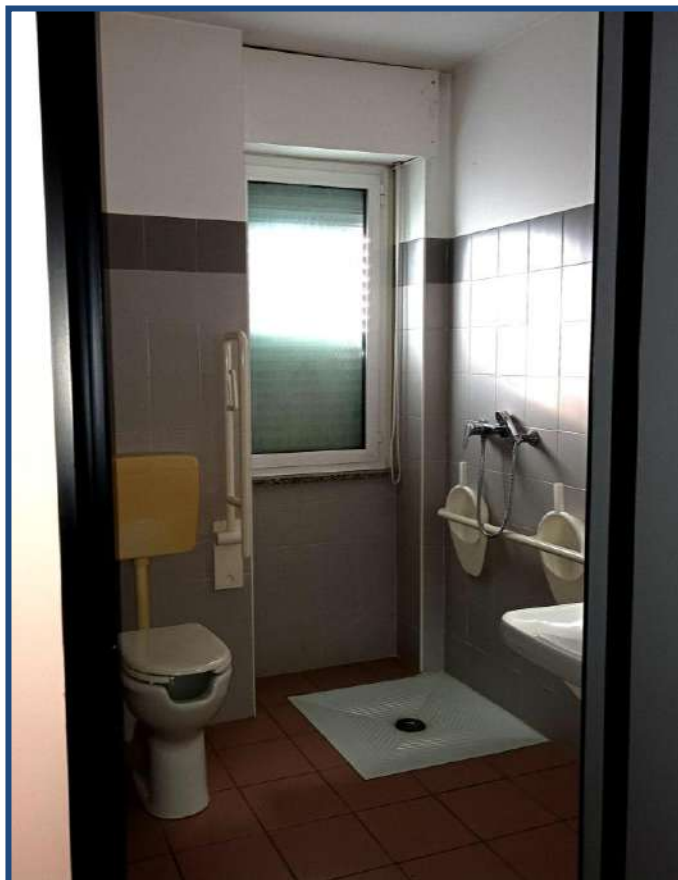
foto 52 - P.1. - Manica Nord-Ovest camera wc annesso
