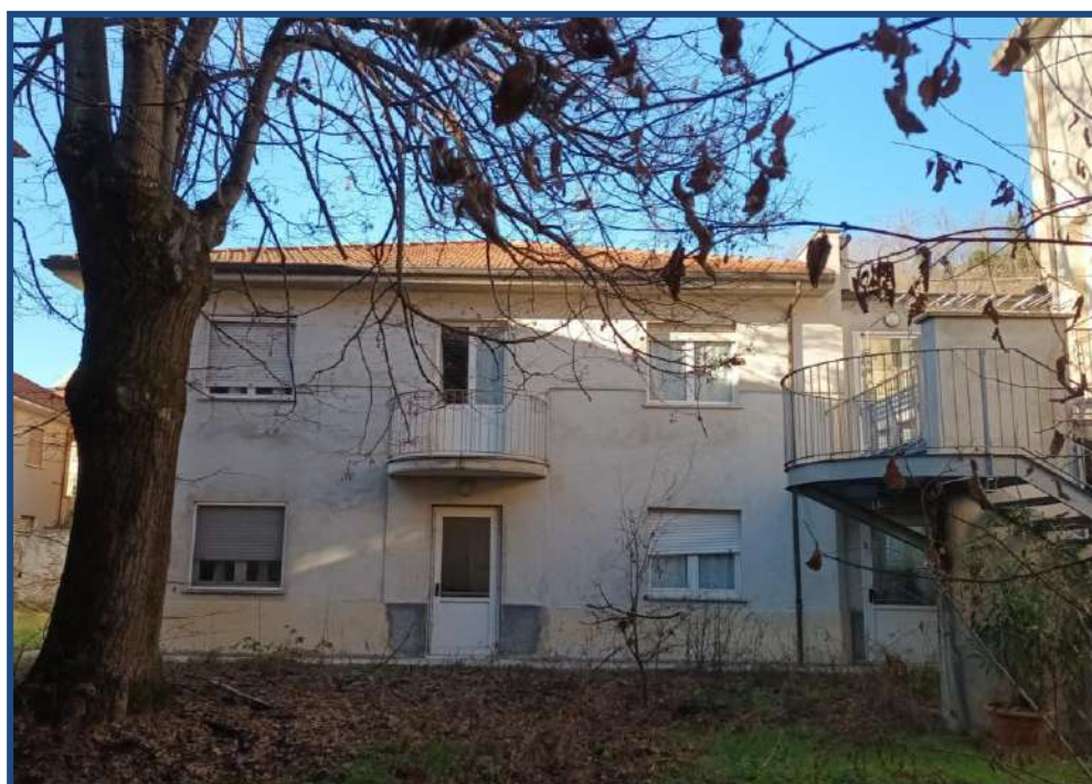
foto 09 - Manica Nord-Ovest vista cortile interno
