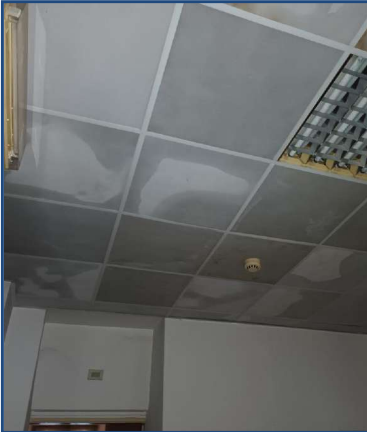
foto 44 - P.1. - Manica Sud-Est disimpegno controsoffitto danneggiato infiltrazioni
