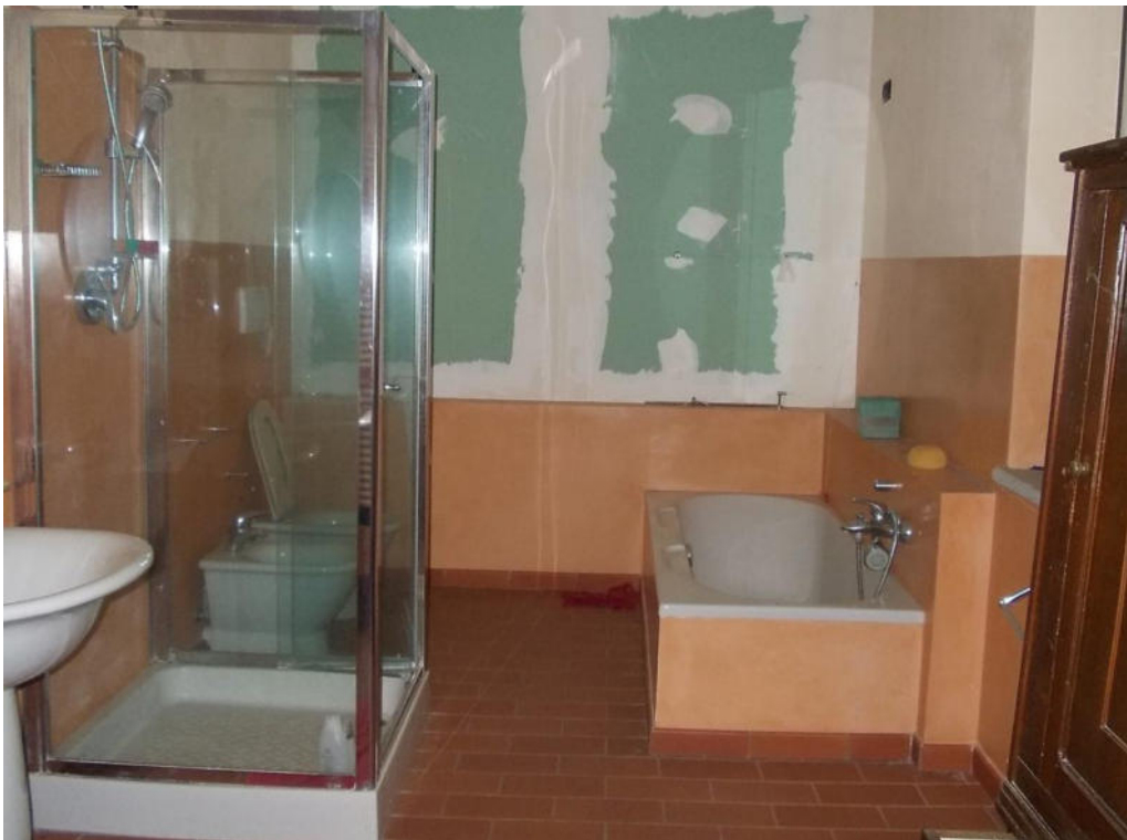
Foto 22 Bagno abitazione p.1 corpo A
