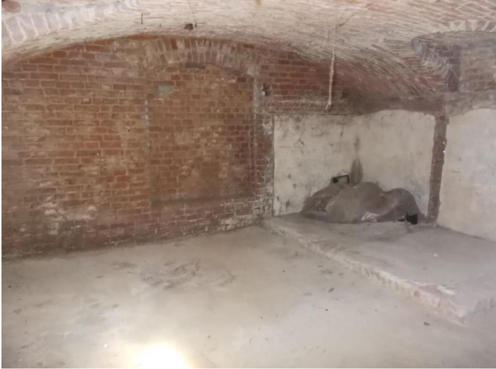
Foto 27 Cantina abitazione p.S1 corpo A
