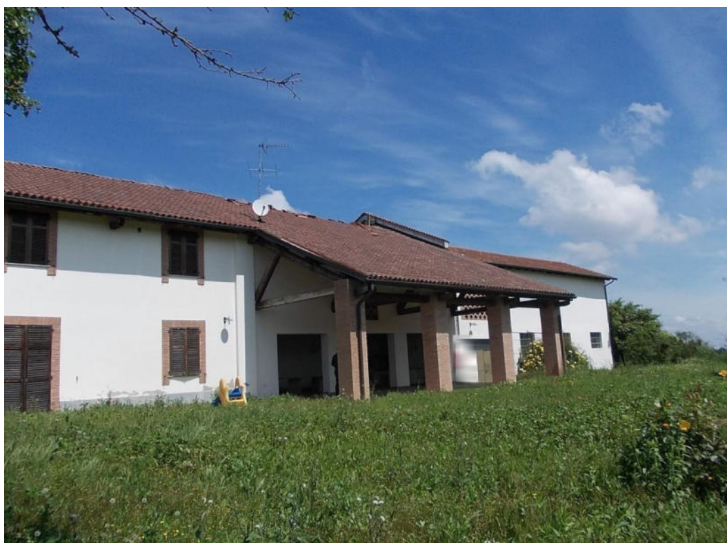
Foto 6 Prospetto sud fabbricati corpo A
