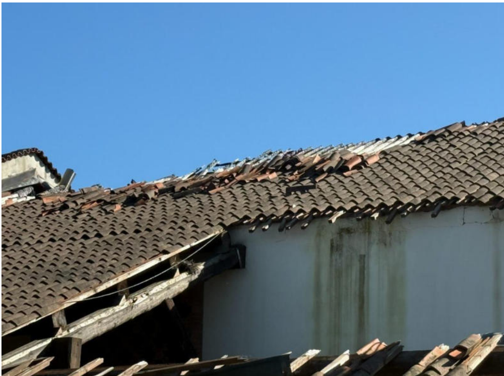
Foto 10 Particolare porzione tetto danneggiata da incendio corpo A
