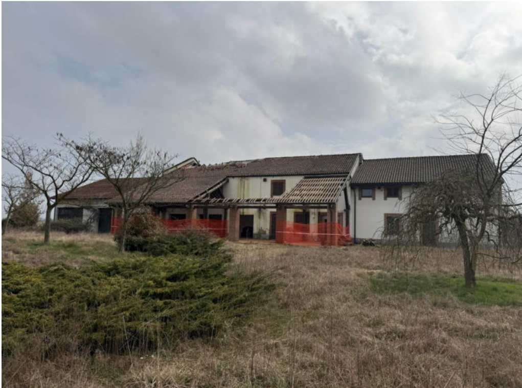
Foto 7 Prospetto nord fabbricati corpo A
