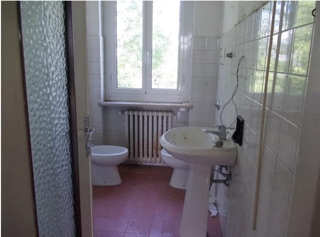
Foto 37 Bagno p.1 “abitazione custode” corpo B
