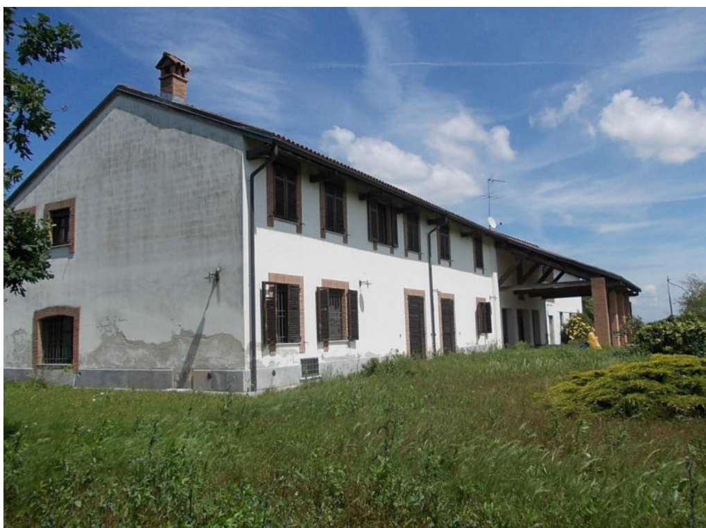
Foto 4 Prospetto sud/ovest fabbricati corpo A
