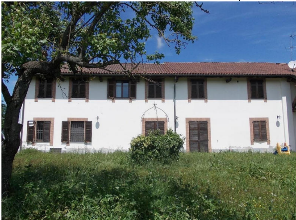
Foto 5 Prospetto sud abitazione fabbricati corpo A
