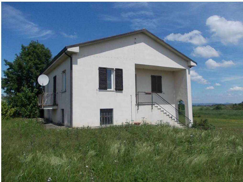
Foto 31 Prospetto sud/ovest "abitazione custode" corpo B
