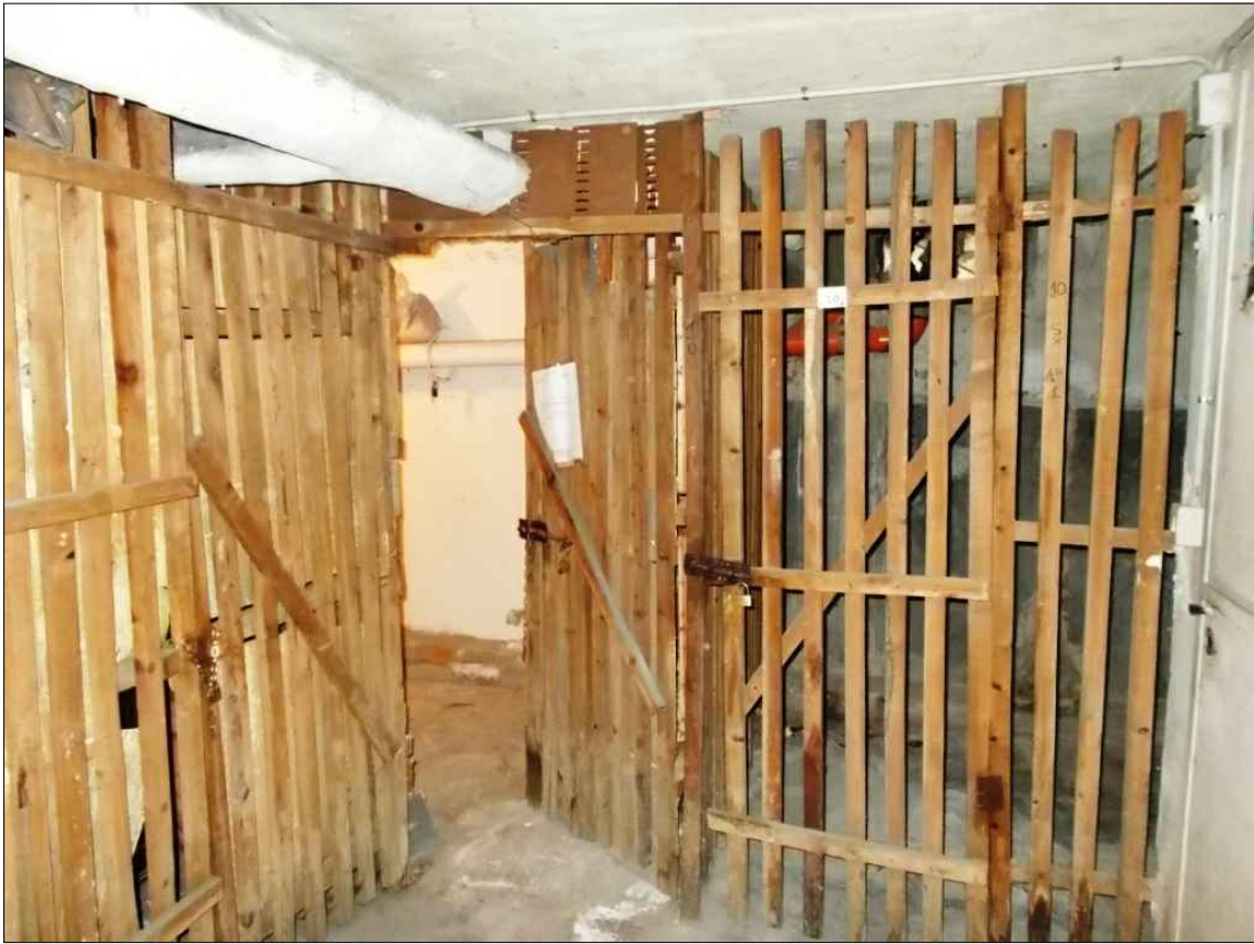
Interni (ingresso cantina)
