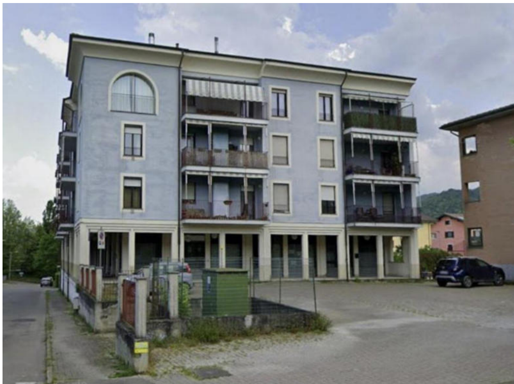
Foto 1 Prospetto ovest Condominio “Azzurro Ventino”
