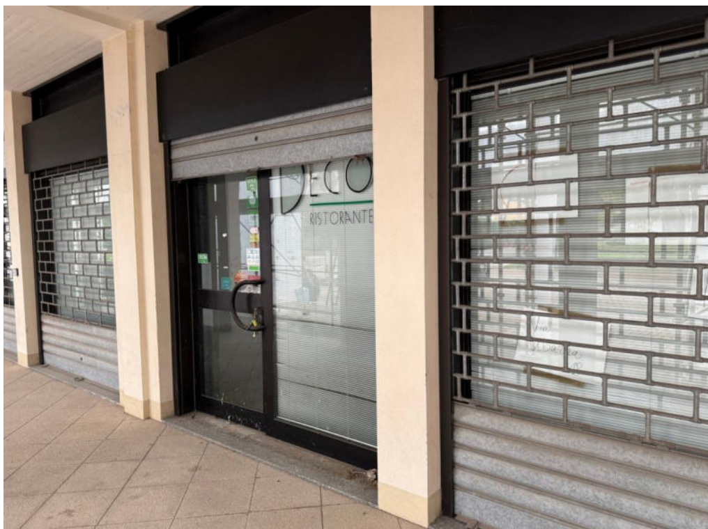
Foto 5 Prospetto ovest da porticato locale commerciale p.t.
