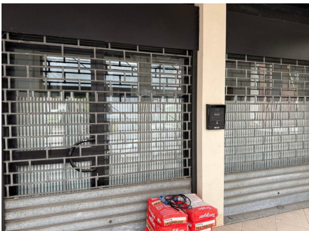
Foto 4 Prospetto ovest da porticato locale commerciale p.t.
