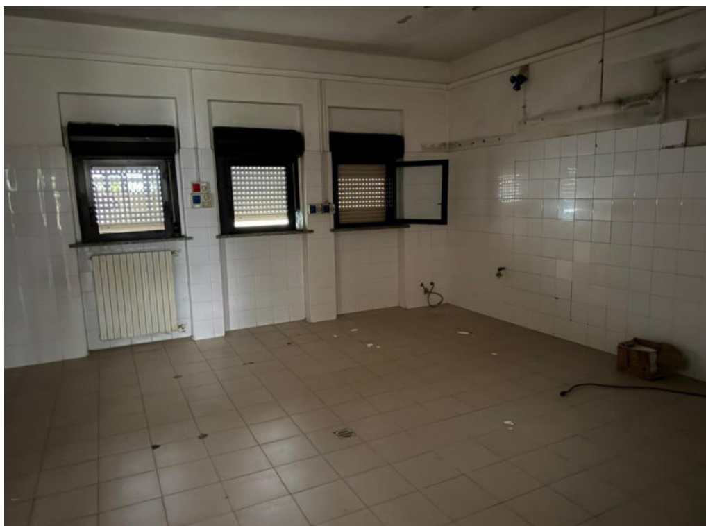
Foto 12 Interno locale commerciale p.t. sub.29
