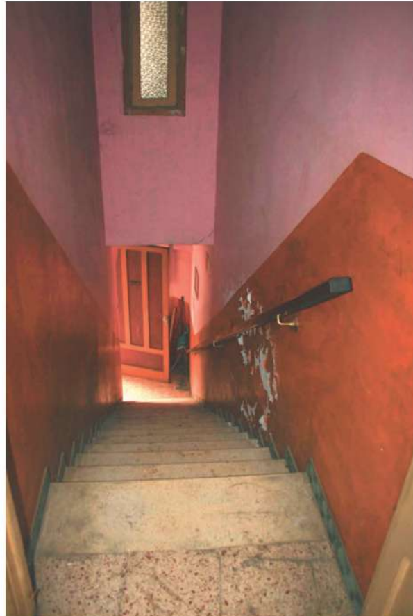
Fig.12-Scala di accesso abitazione pt-p1
