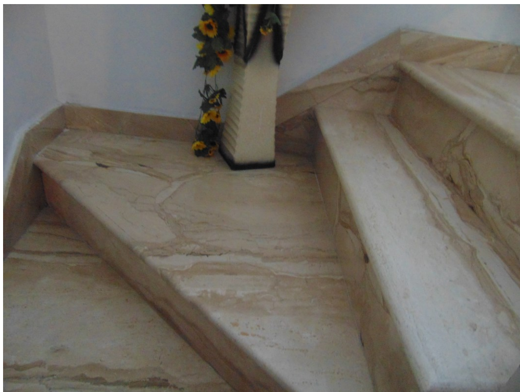
FOTO N.38: dettaglio pavimento in marmo serpeggiante scalinata.
