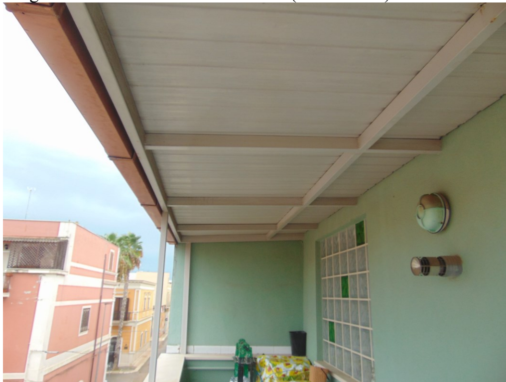
FOTO N.47: particolare copertura metallica veranda secondo piano.
