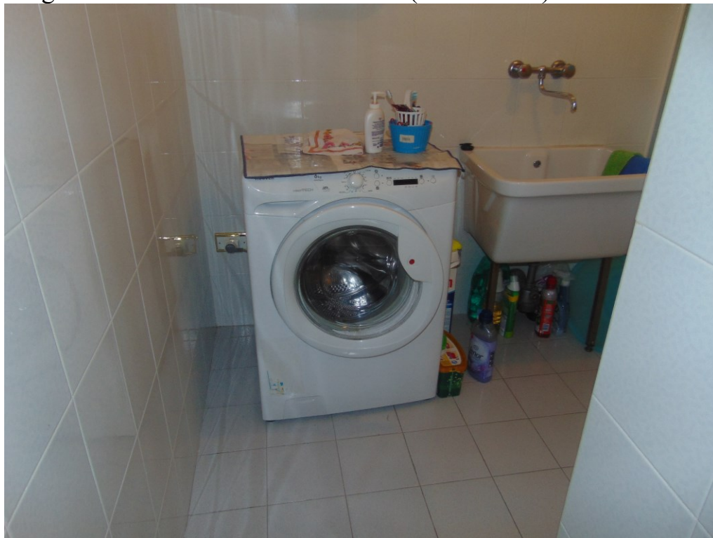
FOTO N.59: bagno - lavanderia al secondo piano.
