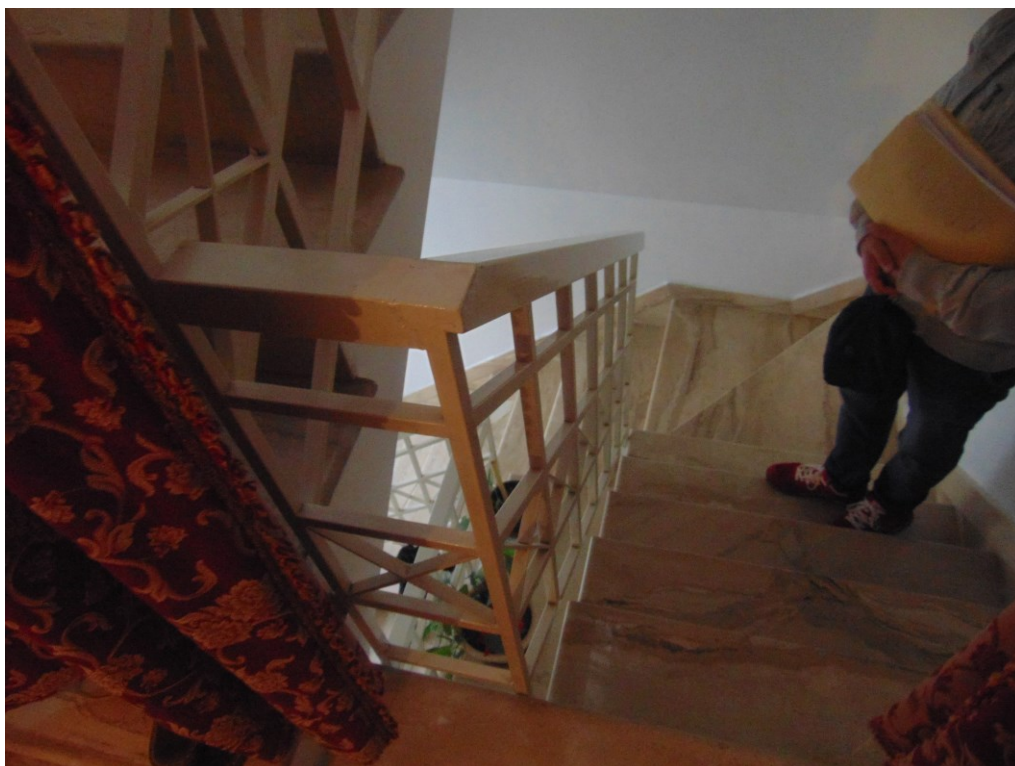
FOTO N.16: particolare scalinata tra piano terra e primo piano Via Palestro n.6.
