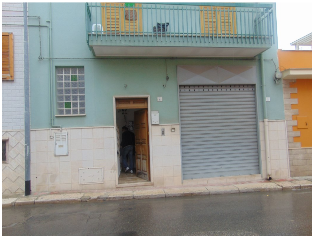
FOTO N.2: Via Palestro n.6: portone di accesso ai piani 1 e 2 in vendita. Contatori idrico e gas sulla sinistra del portone. Civico 4 piano terra a destra non pignorato.
