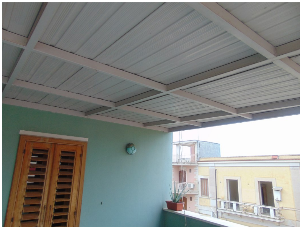
FOTO N.48: particolare copertura metallica veranda secondo piano.
