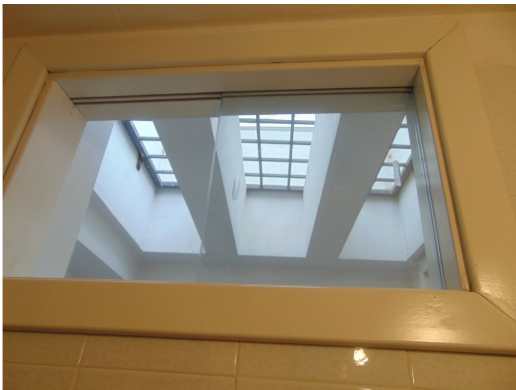
FOTO N.62: pozzo luce secondo piano.
