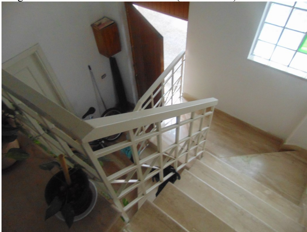
FOTO N.15: particolare scalinata tra piano terra e primo piano Via Palestro n.6.
