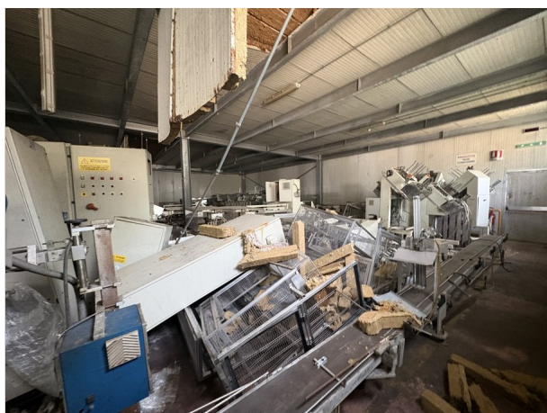
Macchinario scomposto e macerie da cedimento strutturale
