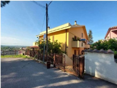
Foto n. 14 – Altra vista laterale di cui alla foto precedente
