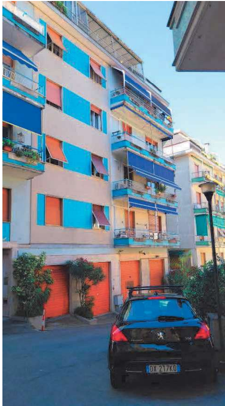
Prospetto edificio visto da est su via Tubino
