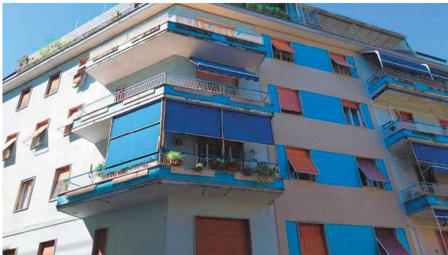
Prospetto edificio visto ( appartamento in oggetto, ultimo piano terrazzo angolare)
