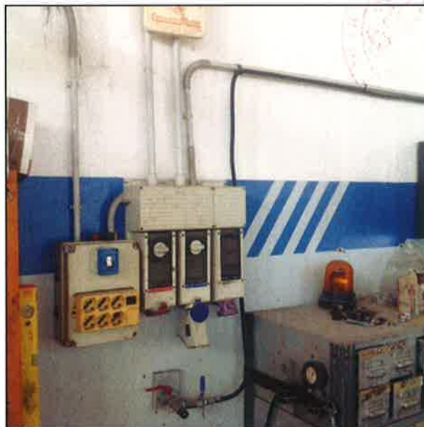
impianto elettrico: quadro generale e blocco prese officina
