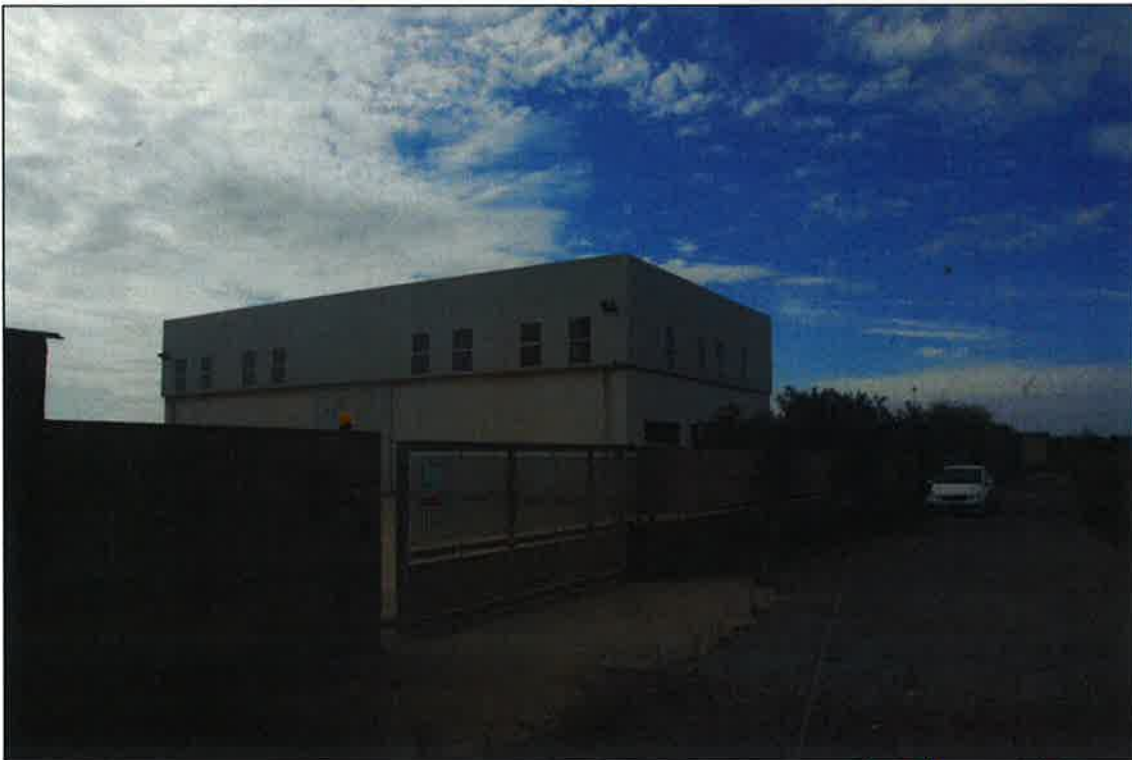
capannone - esterno, recinzione, cancello carrabile
