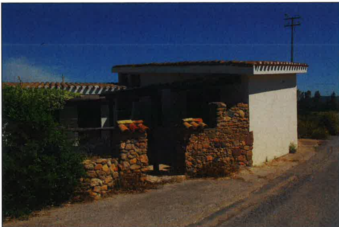
prospetto dalla strada pubblica
