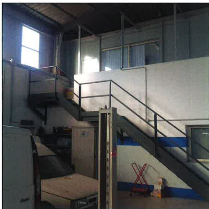
soppalco e scala di accesso
