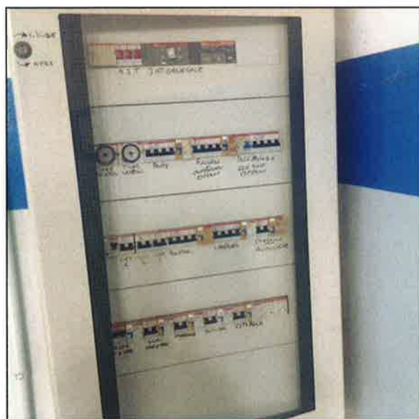
impianto elettrico: quadro generale e blocco prese officina
