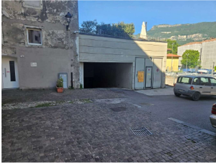
INGRESSO TUNNE DA Vicolo Paiari
