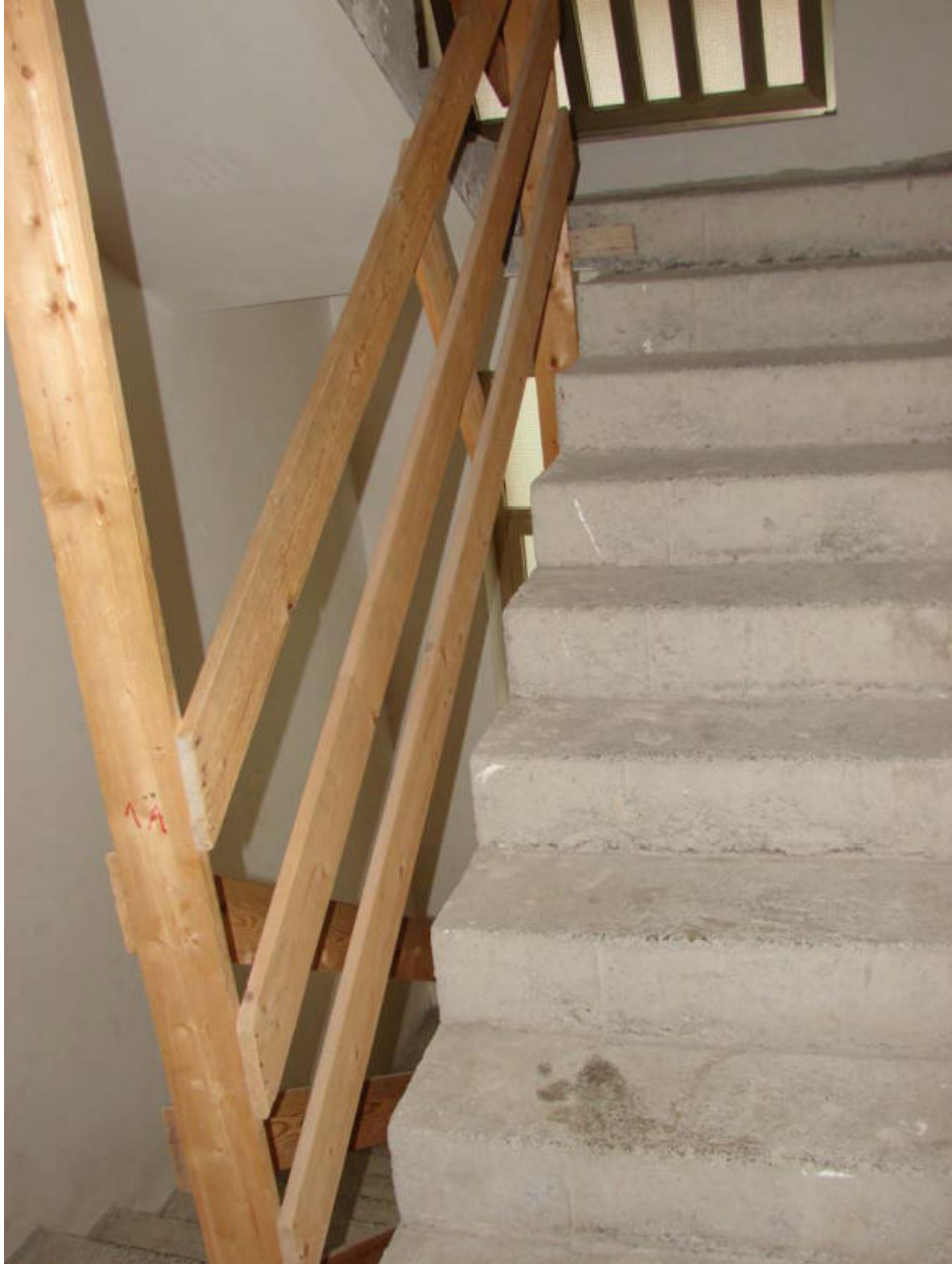
Foto n. 3 – Vista della scala condominiale di accesso all'appartamento
