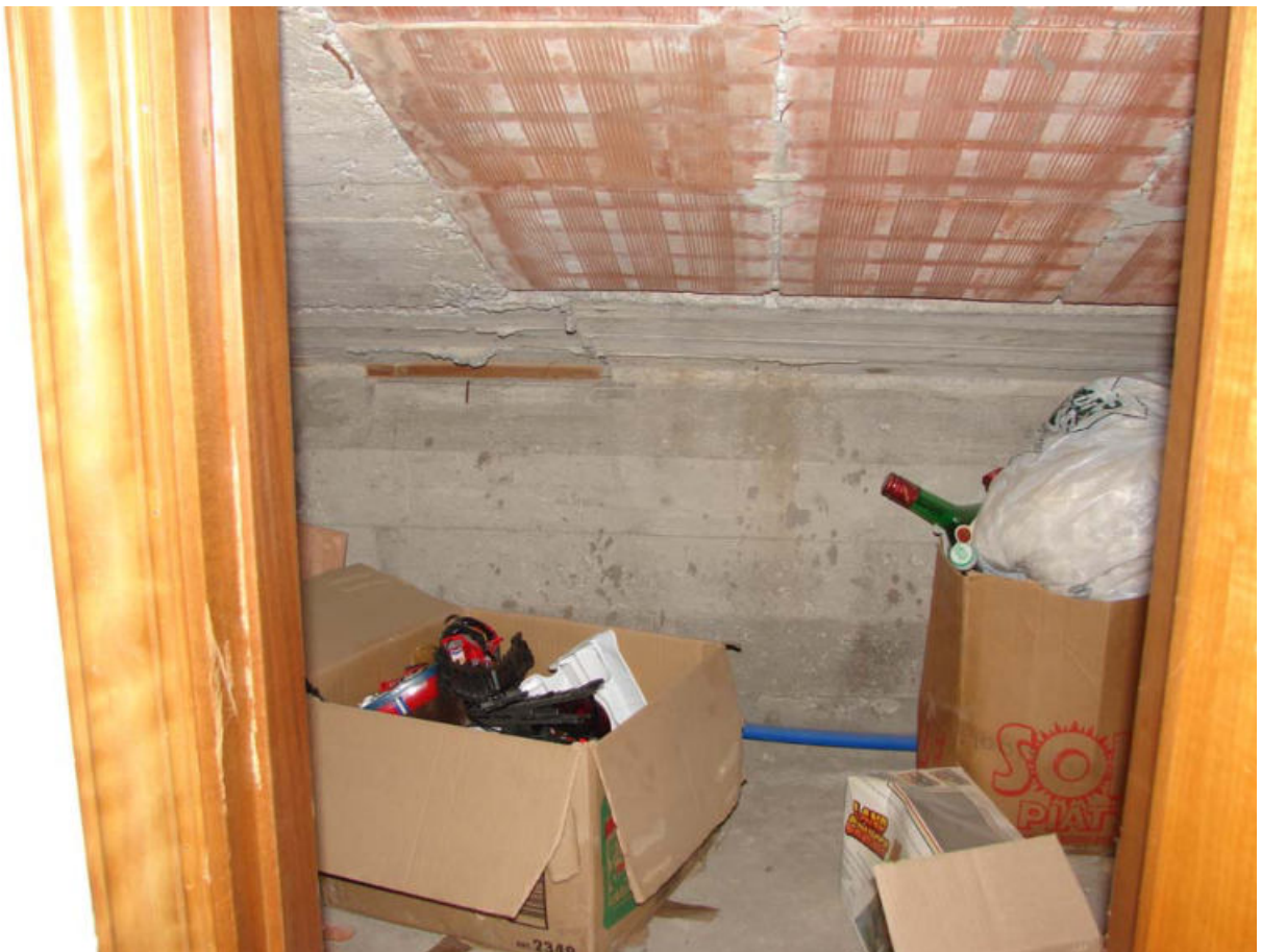
Foto n. 21 – Vista del ripostiglio 4 al terzo piano
