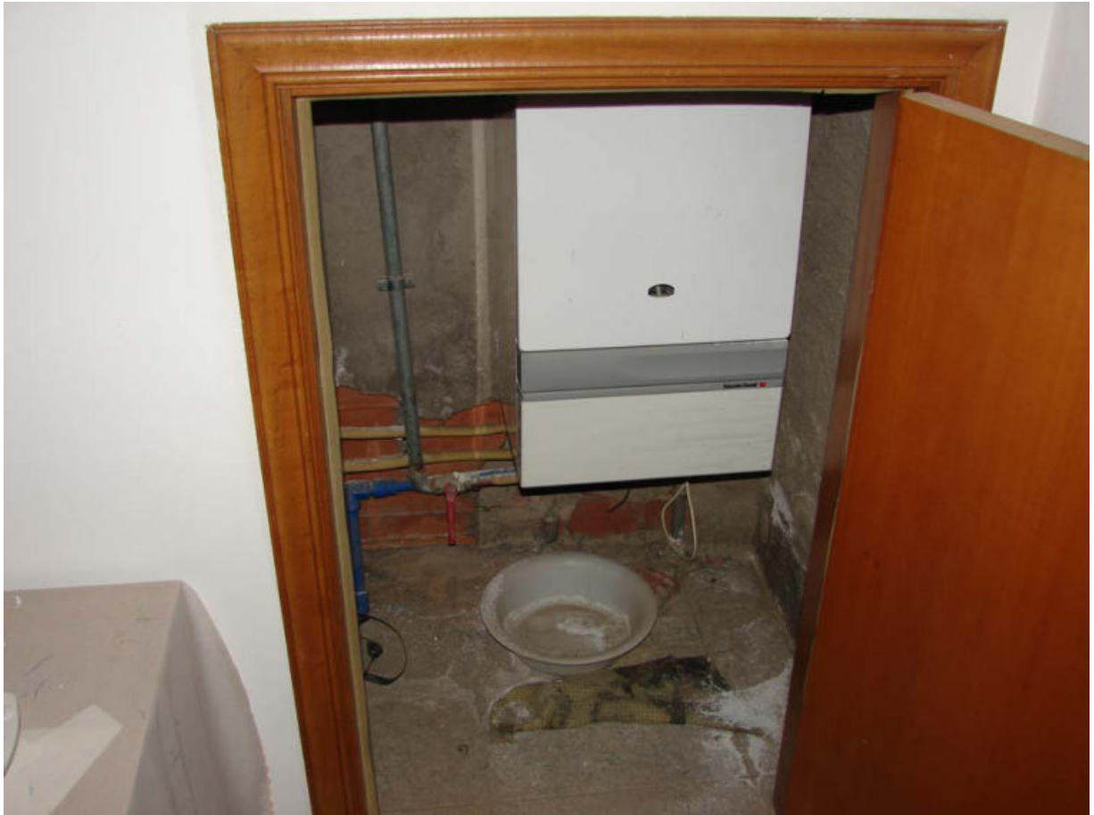
Foto n. 20 – Vista del ripostiglio 3 al terzo piano
