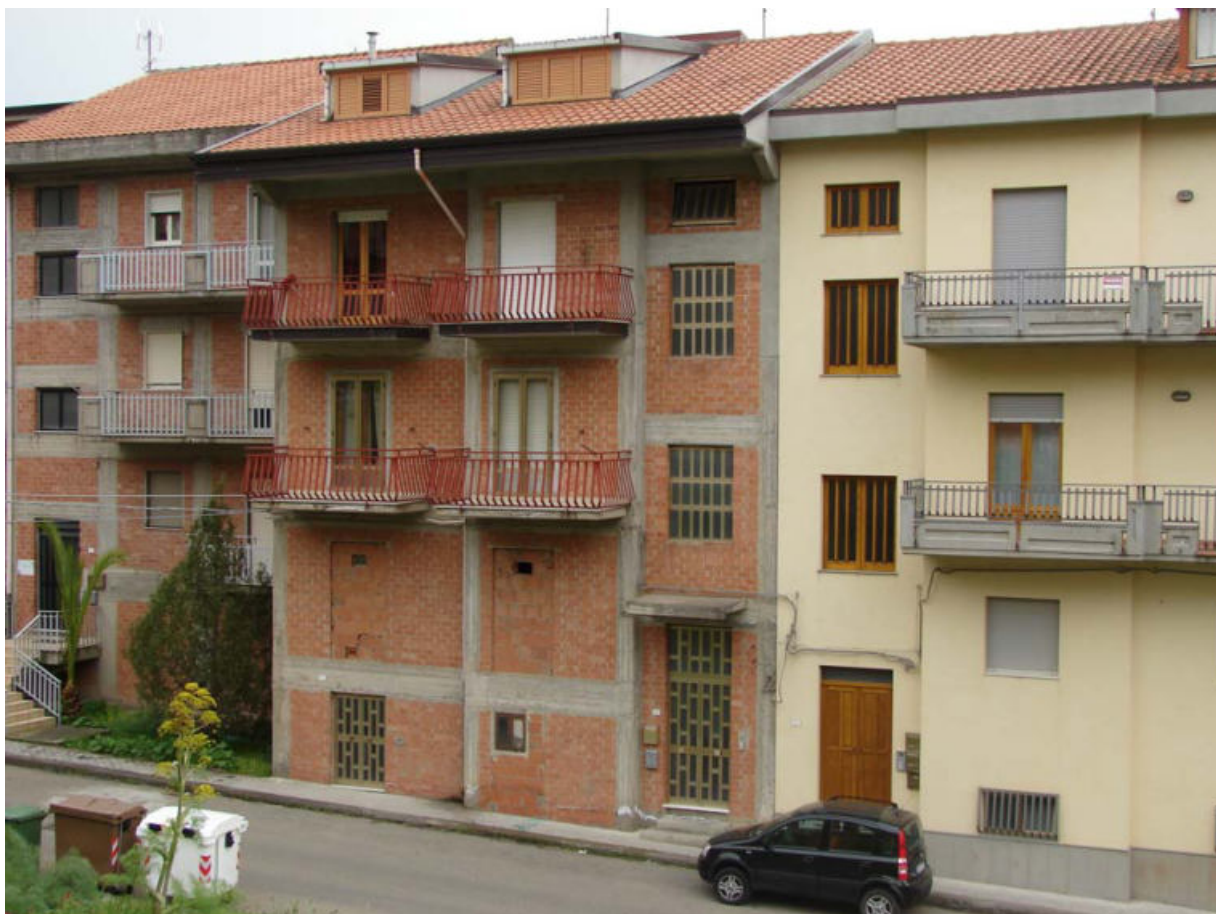
Foto n. 1 – Vista del fabbricato in cui ricade l'appartamento oggetto di pignoramento dalla via U. Giuffrida
