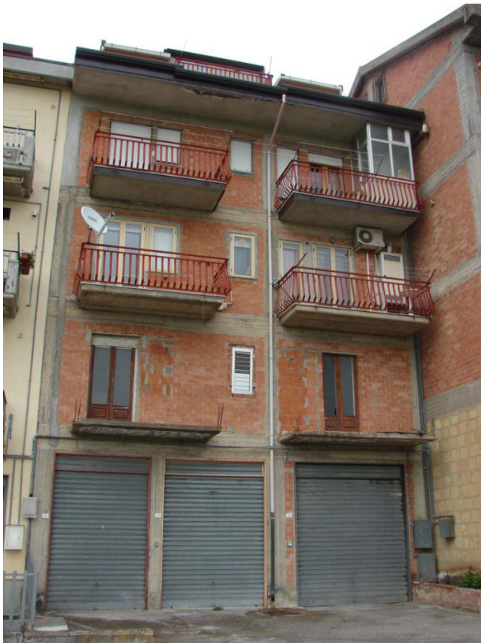
Foto n. 2 – Vista del fabbricato in cui ricade l'appartamento oggetto di pignoramento dalla via E. Berlinguer
