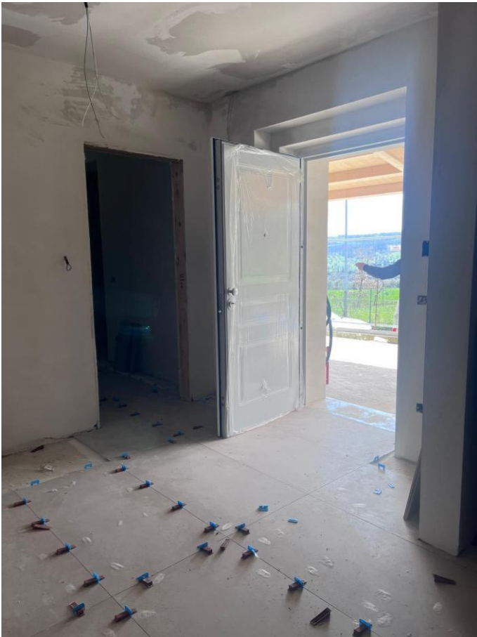
piano terra – ingresso
