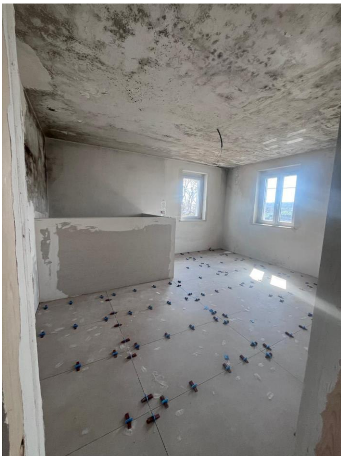
piano primo-camera lato ovest
