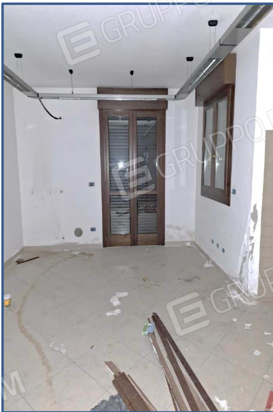
Foto 32 – stato interno unità
