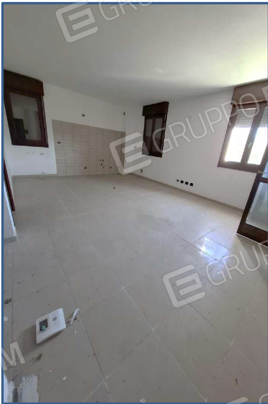
Foto 24 – stato interno unità
