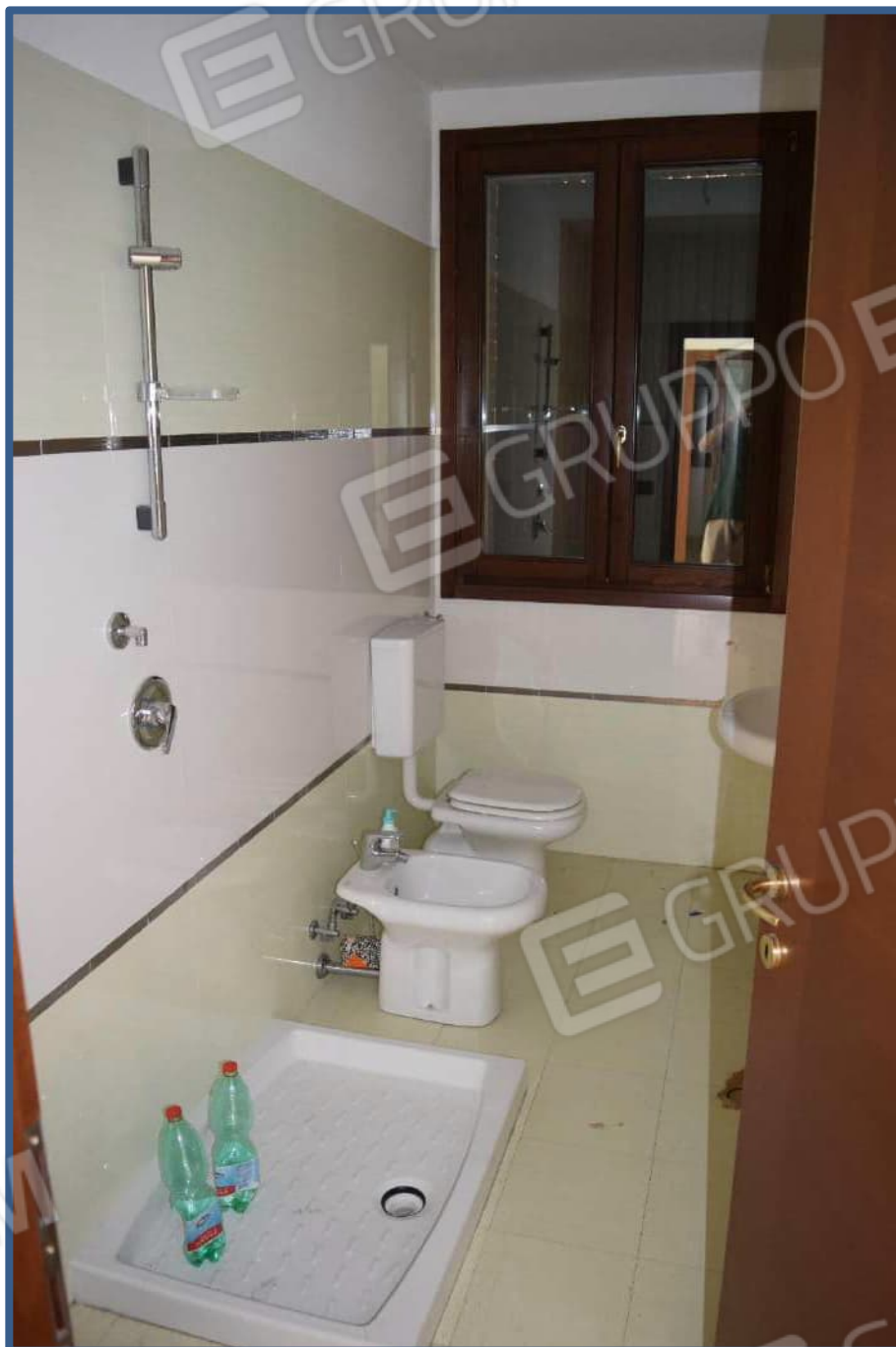
Foto 12 – bagno piano primo
