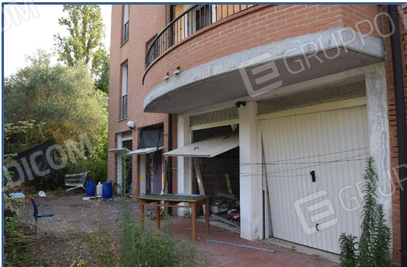
Foto 36 - garage piano terra
