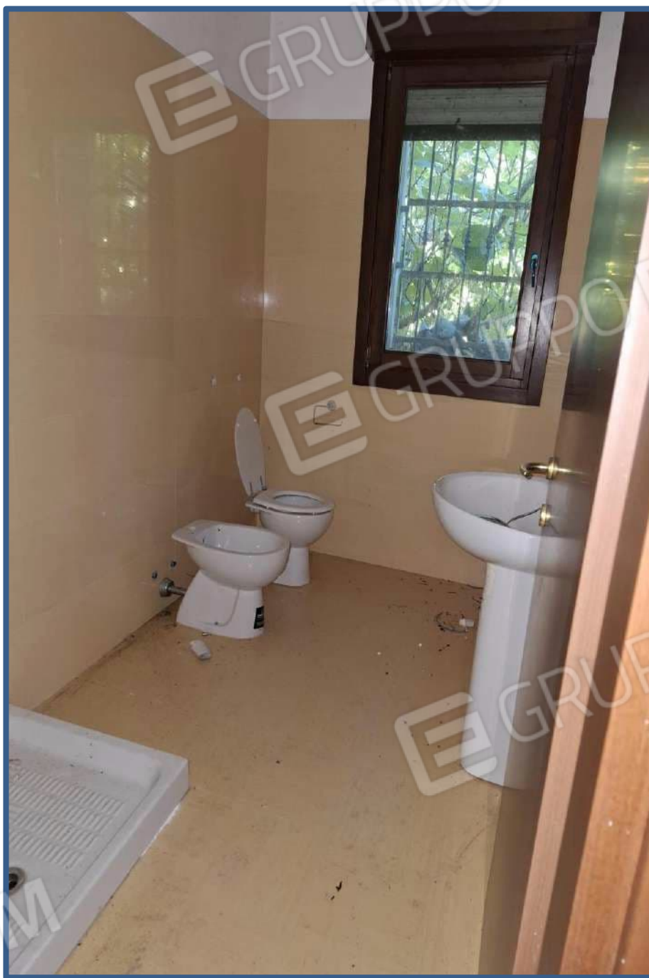
Foto 33 – stato interno unità
