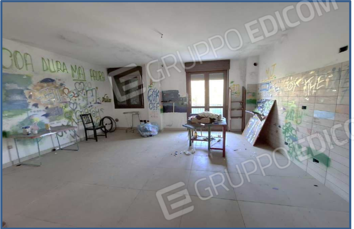
Foto 26 – stato interno unità
