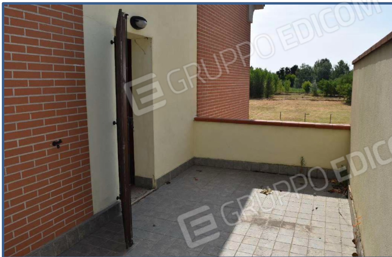
Foto 14 – terrazzino piano primo sopra garage
