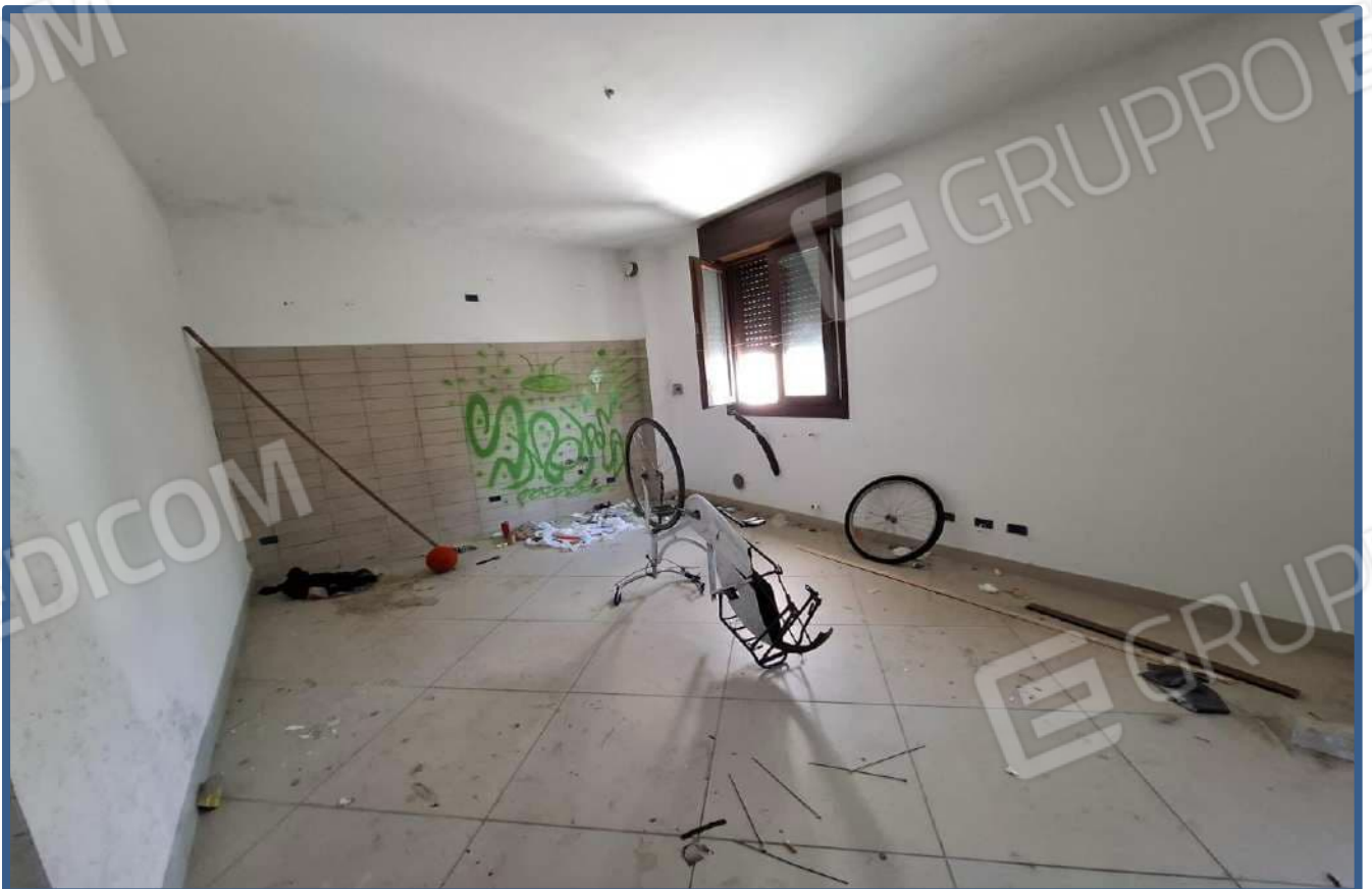
Foto 27 - stato interno unità
