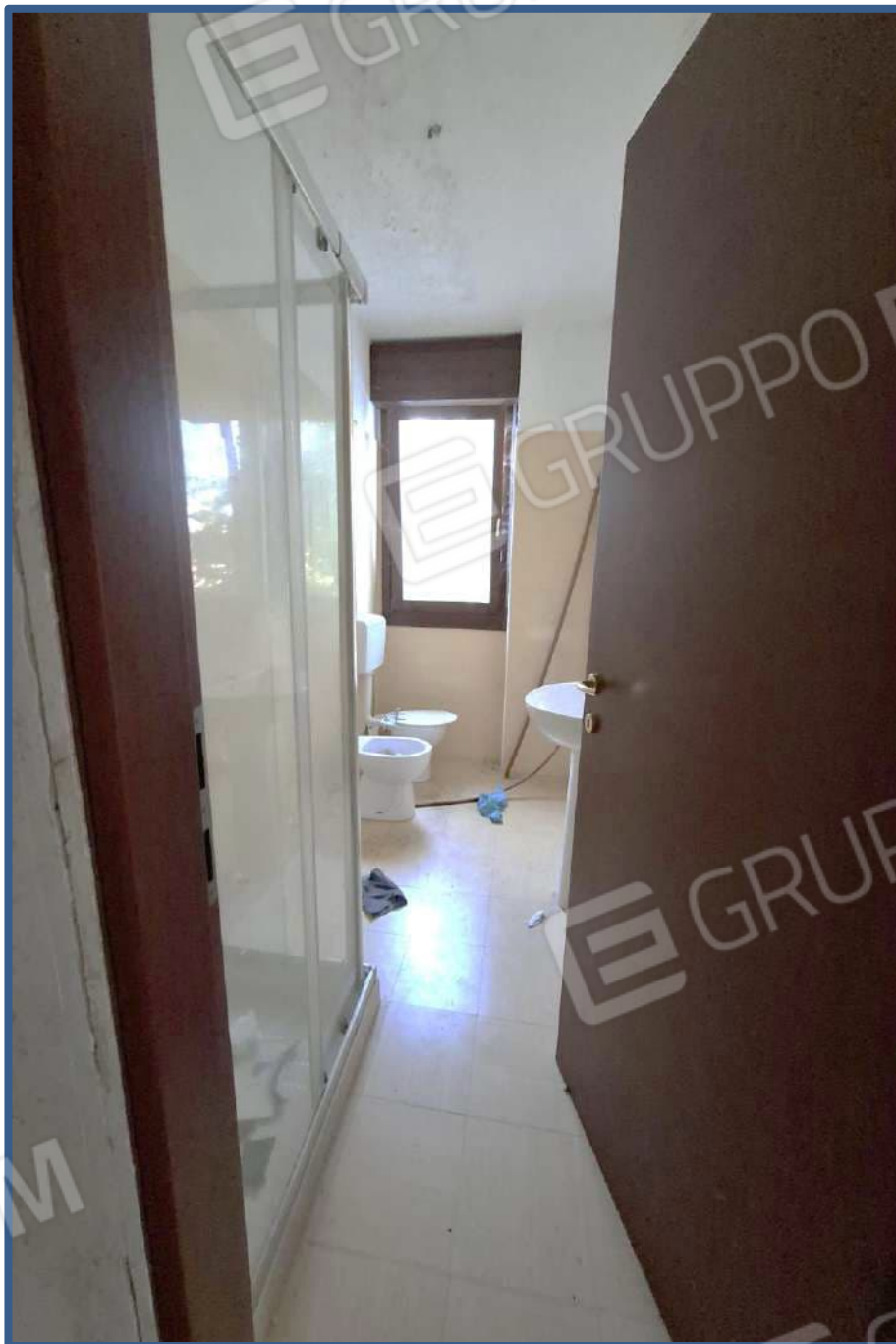
Foto 28 – stato interno unità
