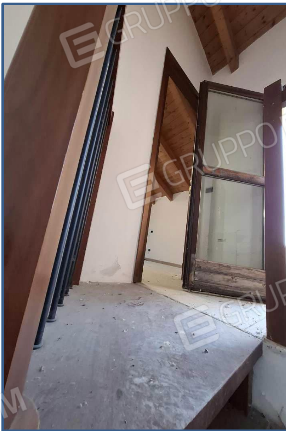
Foto 34 – stato interno unità
