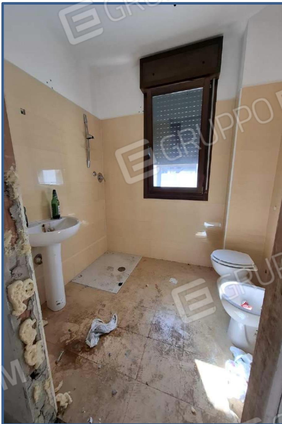
Foto 30 – stato interno unità
