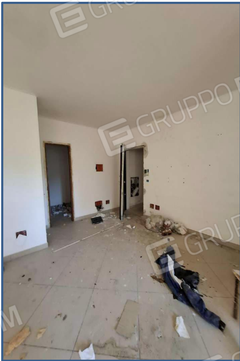
Foto 31 – stato interno unità
