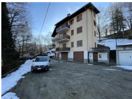
Fabbricato e piazzale condominiale
