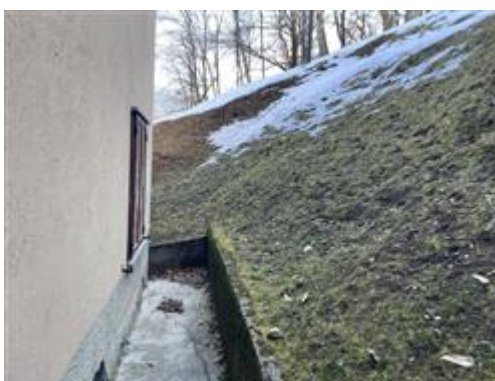
Area a sud dell'appartamento (porzioni parzialmente sotto il livello del terreno)
