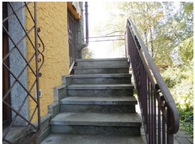
Scala di accesso al 1 piano
