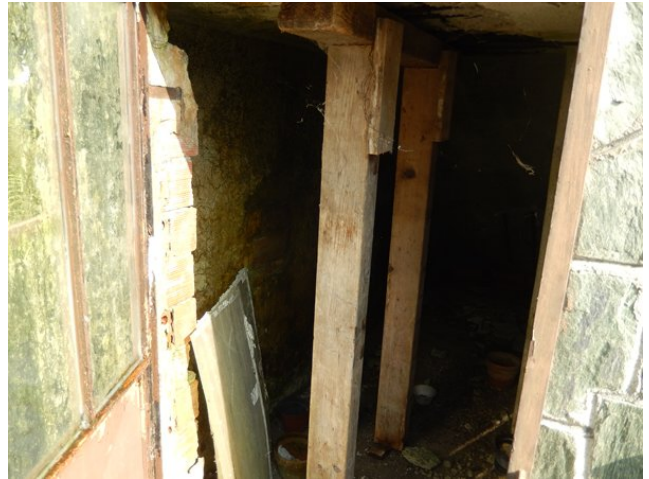
Ripostiglio (realizzato nel sottoscala)
