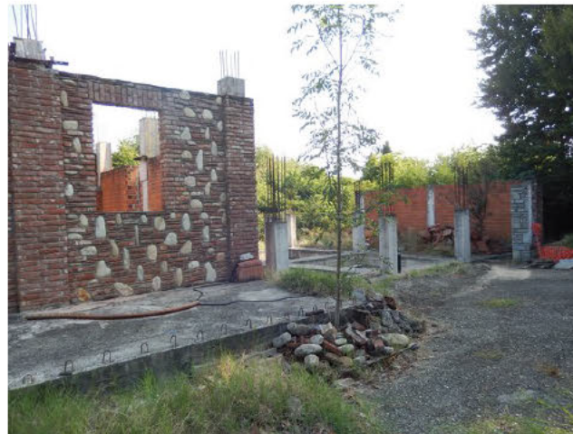
Struttura esterna parzialmente edificata
