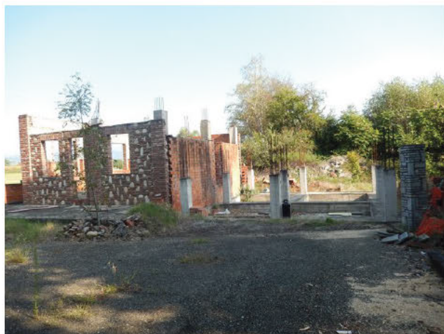
Struttura esterna parzialmente edificata
