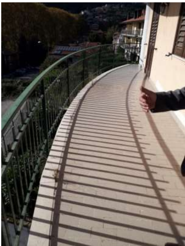
Foto n. 11: il balcone frontale
