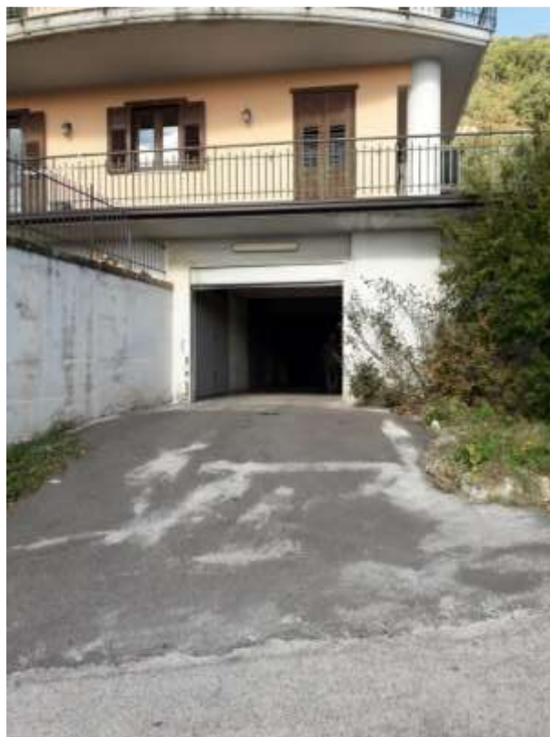
Foto n. 12: l'ingresso al piano seminterrato
