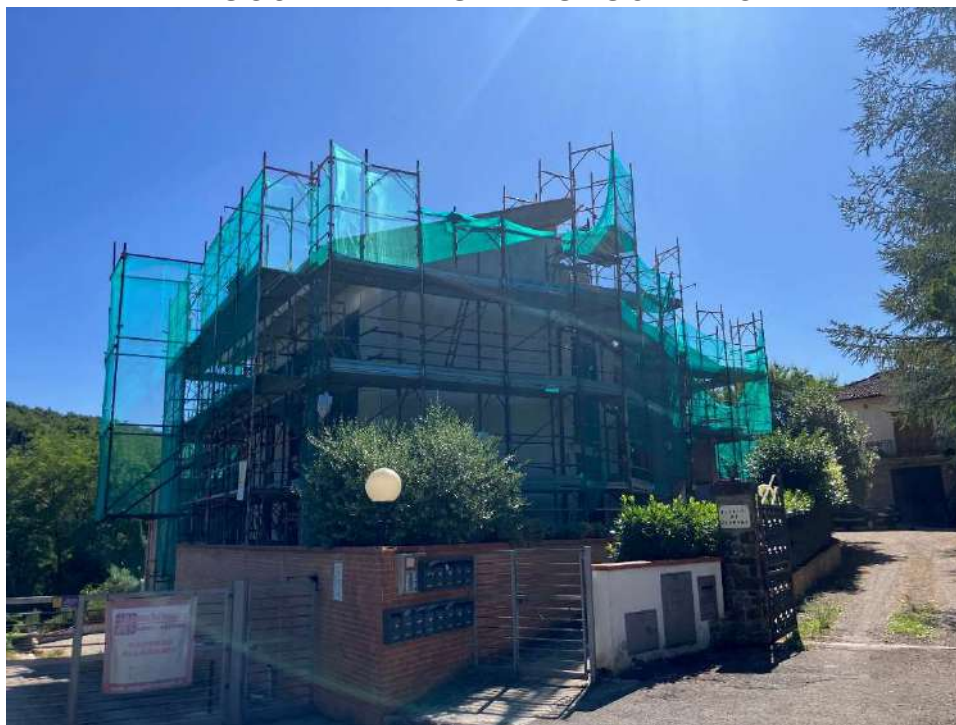
Foto 1 – Il condominio visto dalla via; l'unità in oggetto ha accesso dal resede a comune sul fronte antistante l'edificio. Notasi i ponteggi dei lavori di efficientamento ancora in corso
