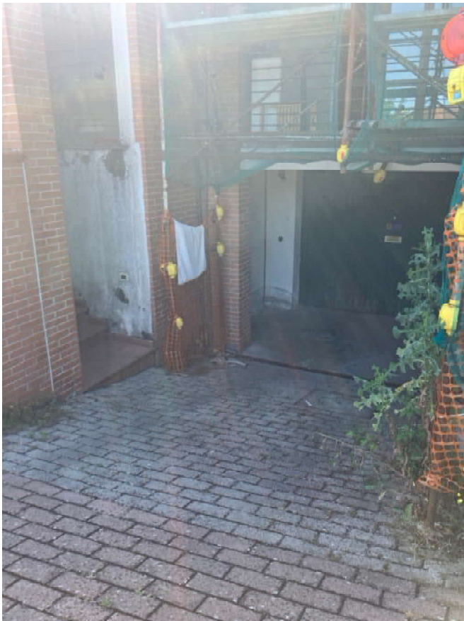
Foto 22 – La rampa di accesso all'ingresso comune dei garage dal quale accede il garage 2
