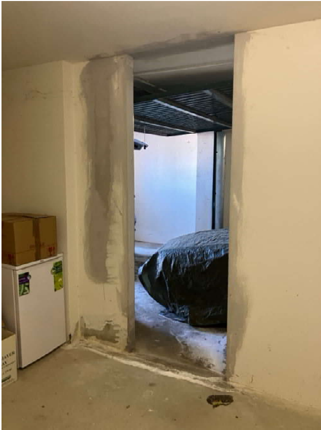
Foto 19 – La porta di collegamento fra i due garage, vista dal garage 2
