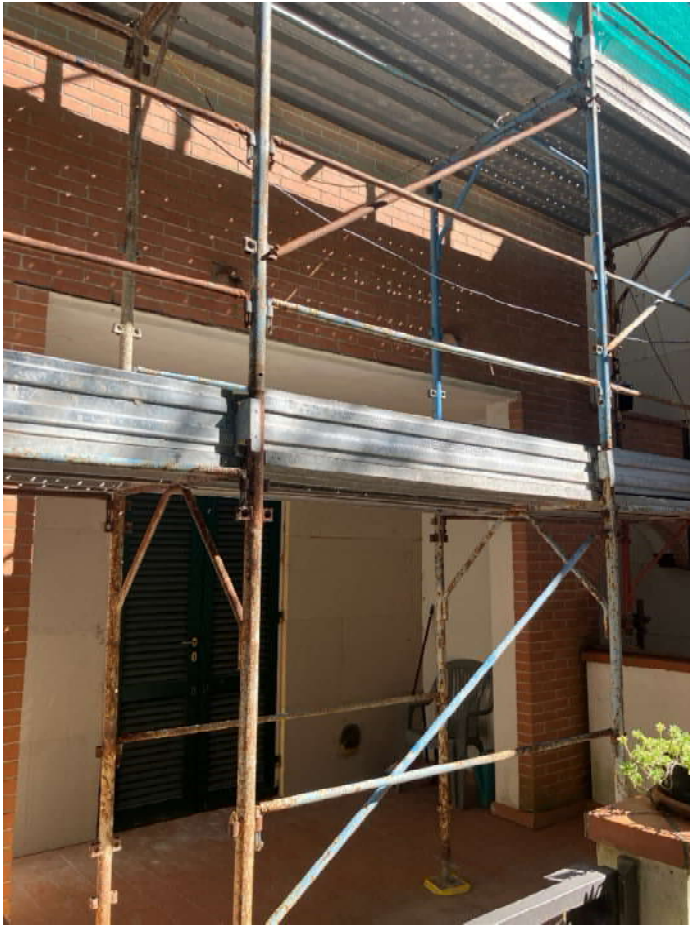
Foto 11 – Il resede tergale occupato dai ponteggi dei lavori in corso
