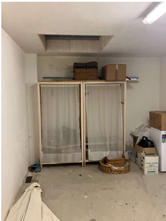
Foto 18 – Il garage 2. Notasi al soffitto la botola di collegamento alla soprastante residenza
