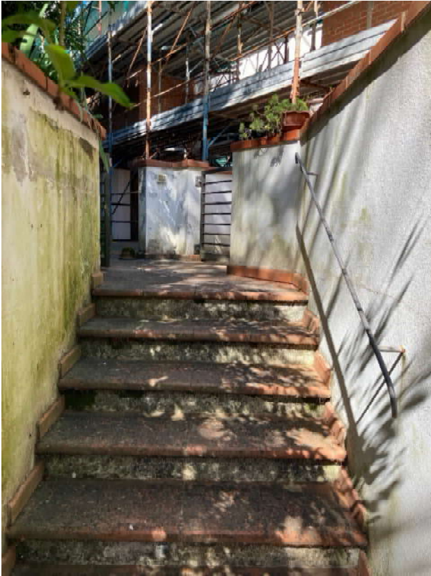
Foto 13 – La scaletta di ingresso al resede dal passaggio interno
