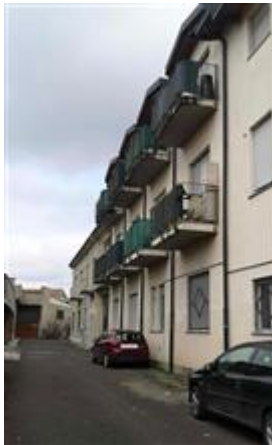
Vista del condominio da Vicolo Como
