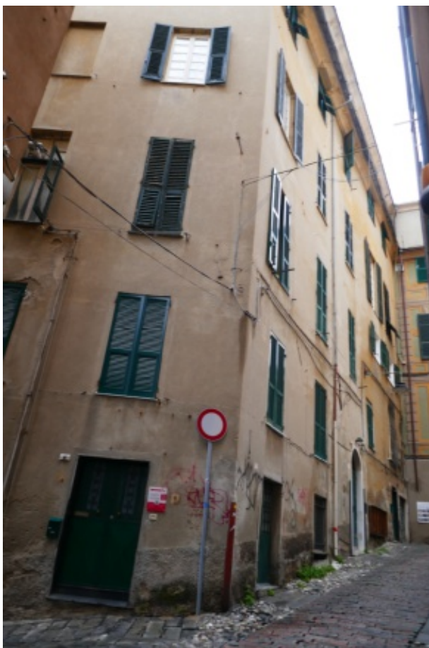
Foto 3 - Vista del portoncino principale di accesso all'immobile dalla sal. S.M. di Castello
