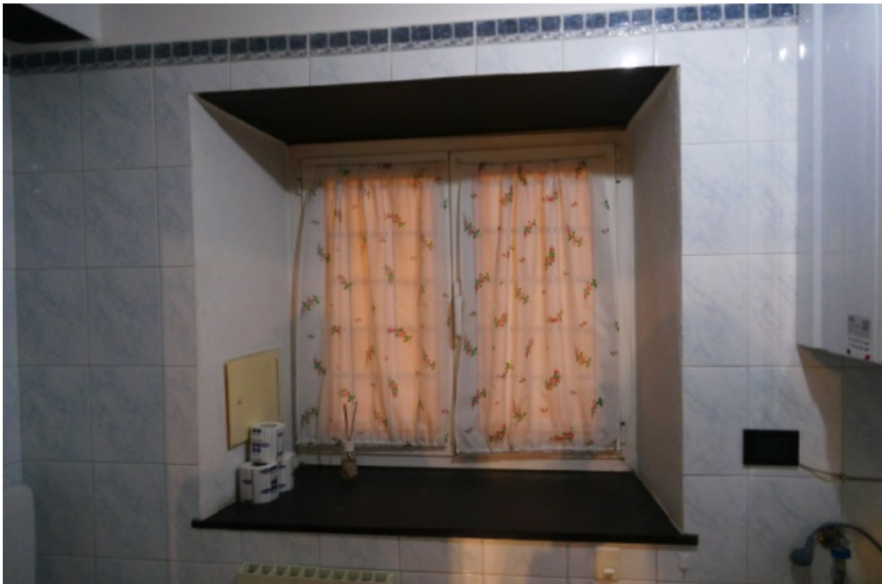
Foto 16 - Vista della finestra del bagno
