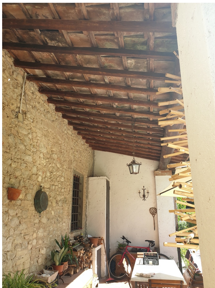
Foto nr. 2 – Loggia
