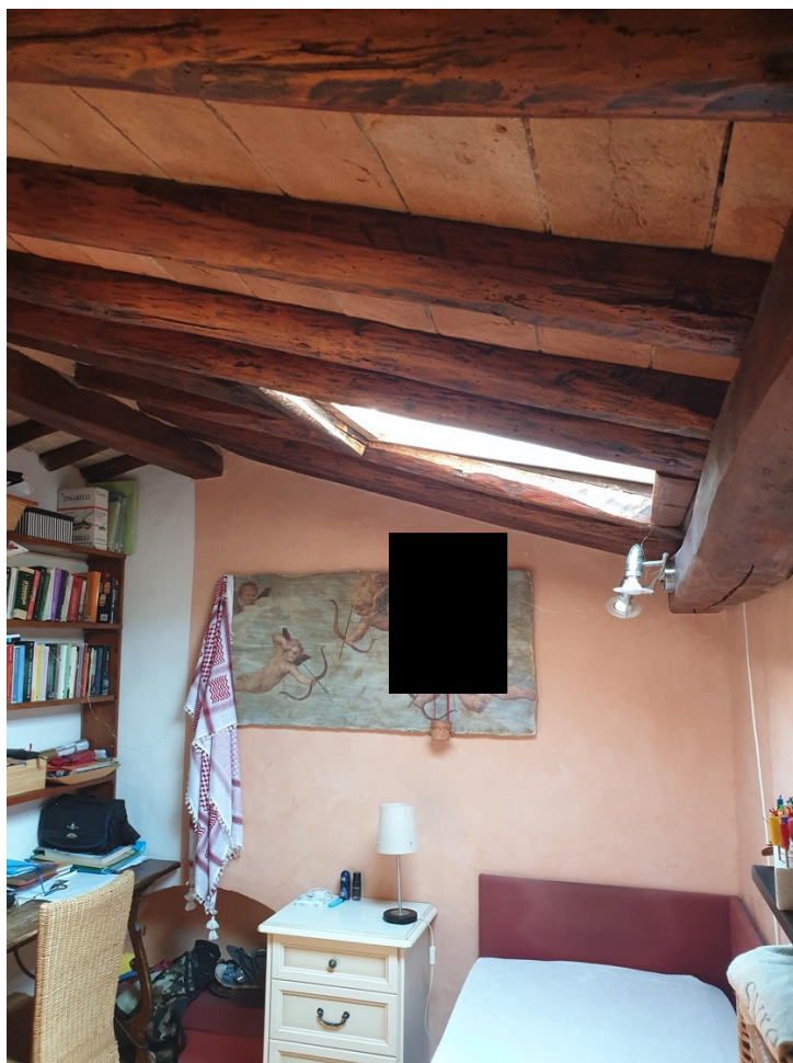
Foto nr. 8 – Sottotetto
