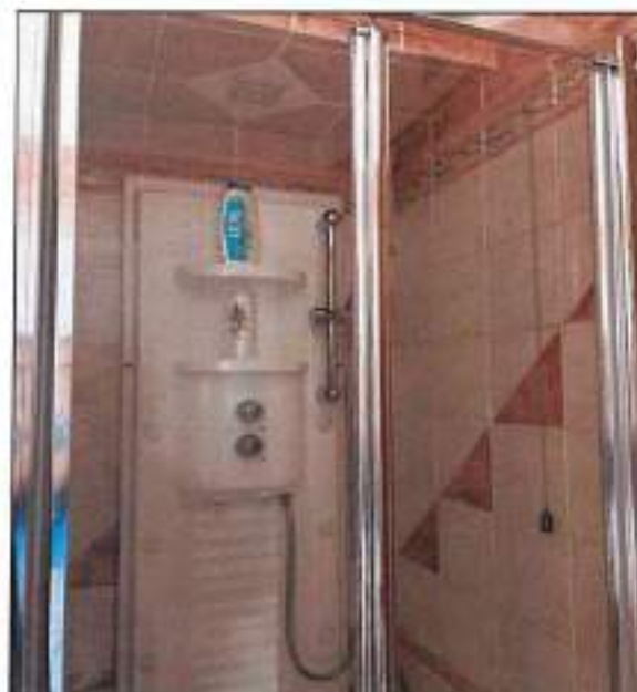
Foto n° 17 – vista locale wc del sub, con pareti completamente rivestite a full'altezza, vista vano doccia con idromassaggi.
