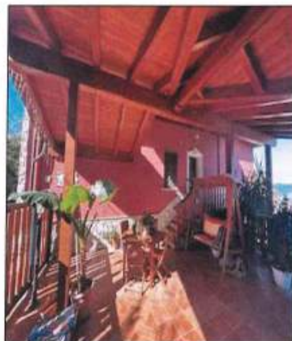
Foto n° 28 – Vista interna tettoia in legno lamellare, di pregio-ale fattura piano Terra- ingresso fabbricato.
