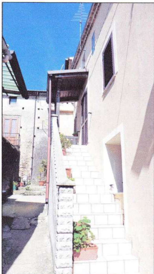
Lato sud-est: scala esterna con tettoia
