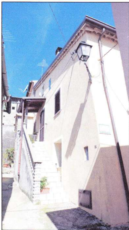
Angolo principale sud-est: scala esterna
