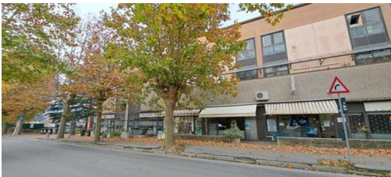
foto 6: vista d'insieme dell'edificio
