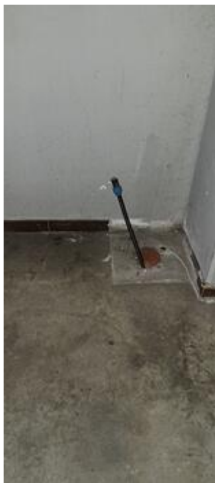
foto 15 e 16: altro quadro elettrico interno all'officina e predisposizione scarico fognario e carico acqua a pavimento nell'officina per eventuale bagno nel civ. 13G.
