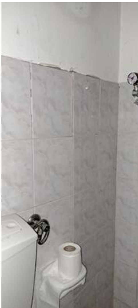
foto 6, 7 e 8: bagno: areazione meccanica, piastrelle in distacco, predisposizione per Boiler
