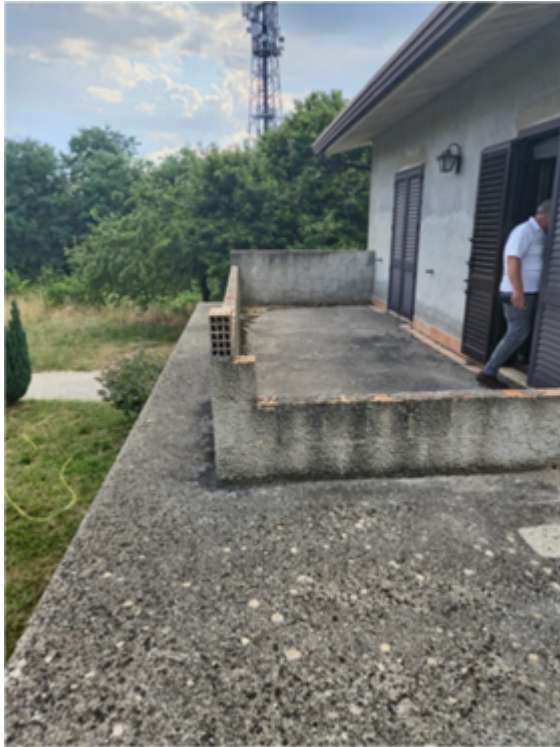
foto 16 (terrazzo lato SUD)
