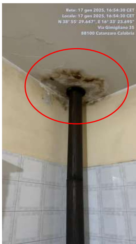
Foto 19. Particolare innesto canna fumaria stufa nel solaio
