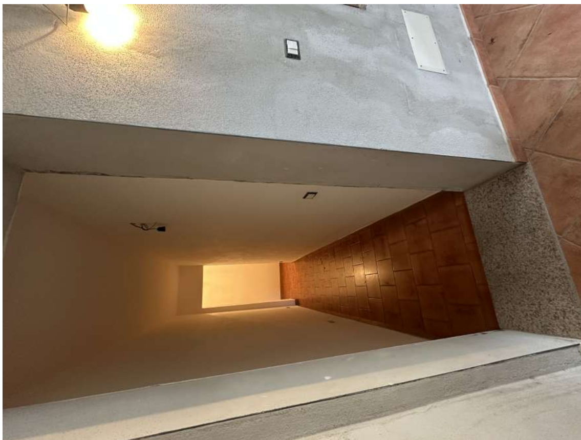
Foto 40 – ingresso appartamento “A” piano primo
