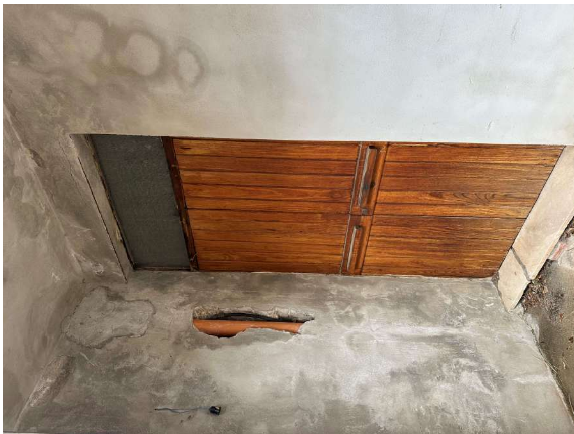
Foto 31 – portoncino ingresso al piano terra
