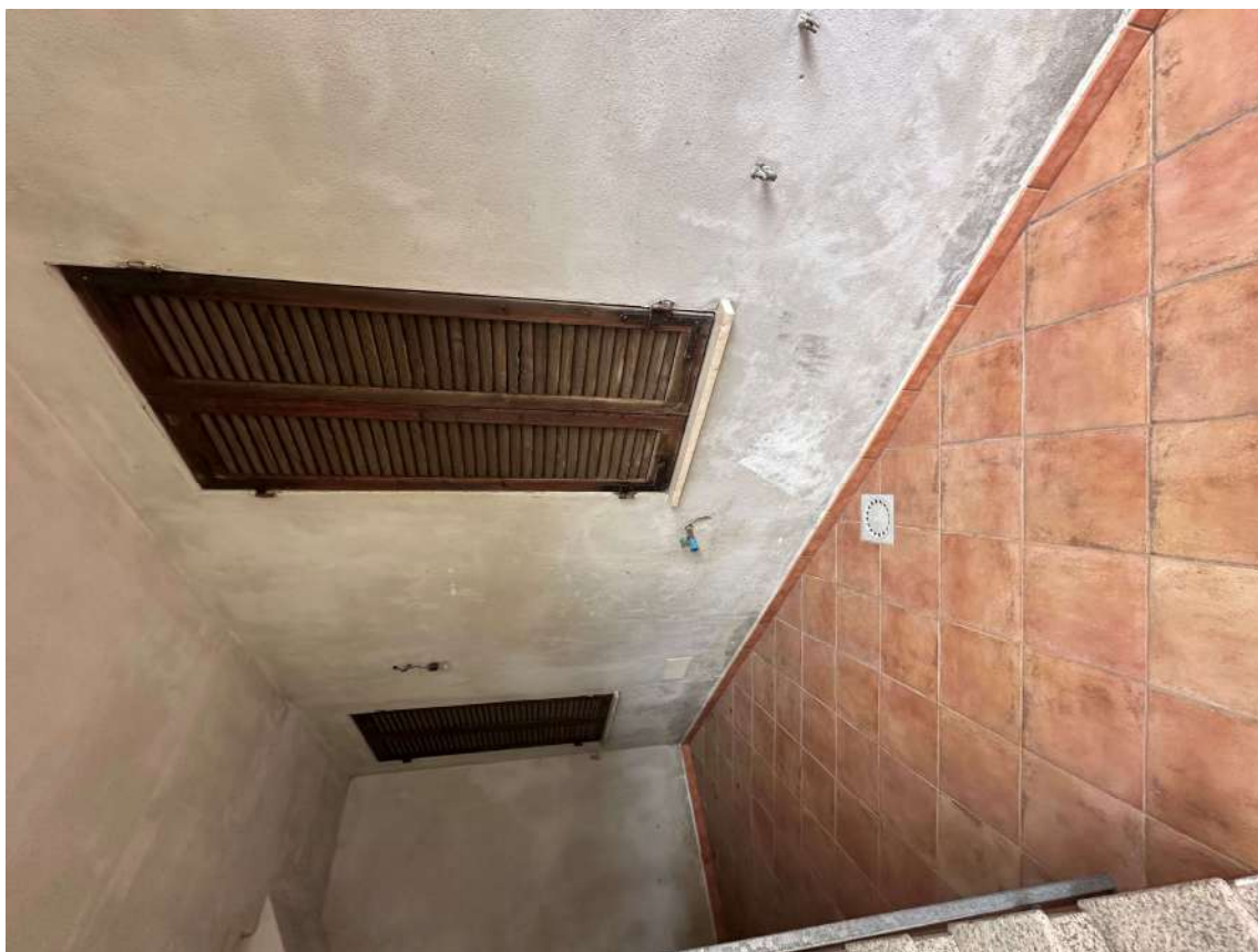
SCALA INTERNA ACCESSO PIANO PRIMO E SECONDO
