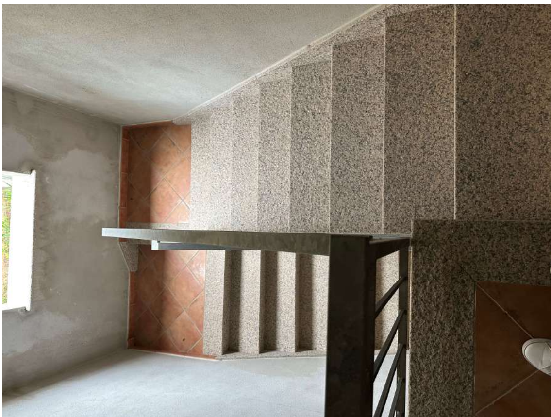
Foto 38 – scala tra piano secondo e primo
