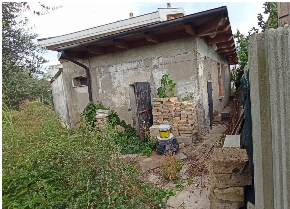
Locali deposito e wc posti nel corpo di fabbrica laterale
