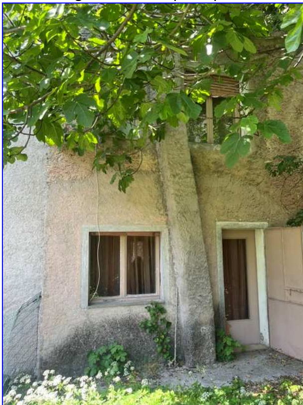
Vista uscita sul giardino SUB 2 piano primo fronte nord
