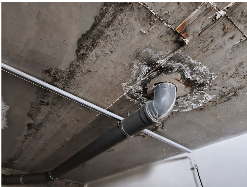
Foto n.22 (Particolare infiltrazione)
