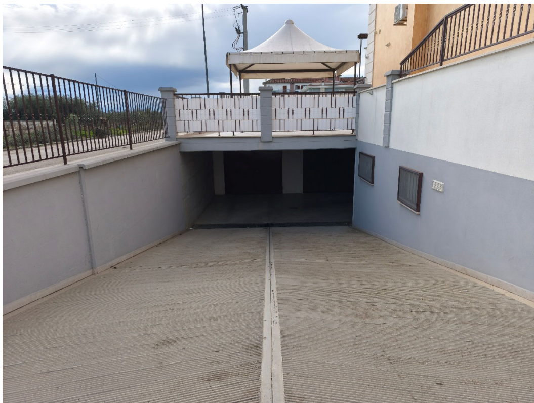
Foto n.17 (Ingresso piano interrato)
