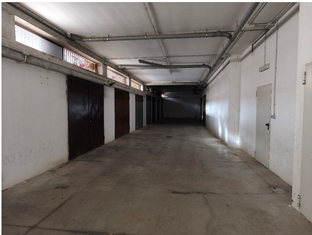
Foto n.19 (Area di manovra)
