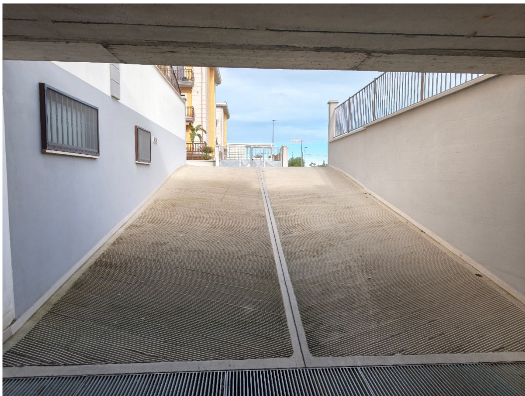
Foto n.18 (Ingresso piano interrato)
