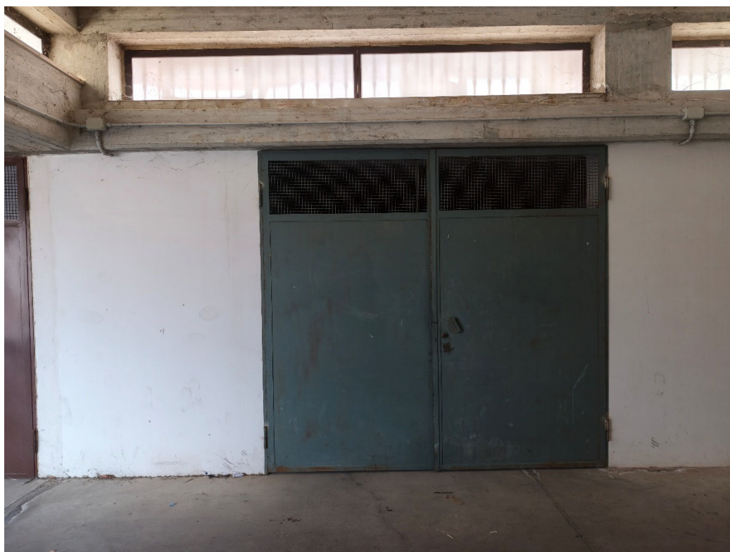
Foto n.20 (Porta ingresso autorimessa)
