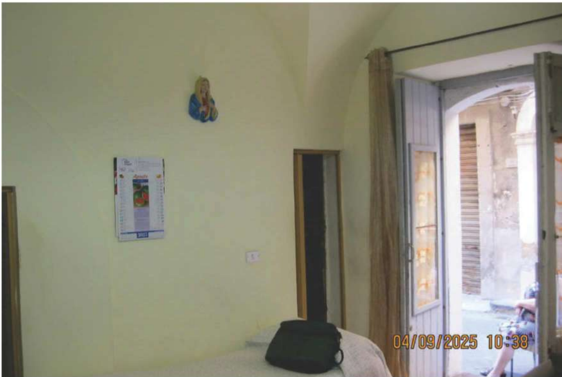
Foto 21: il vano al piano terra
