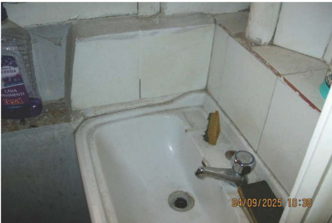
Foto 29: il bagno al primo piano
