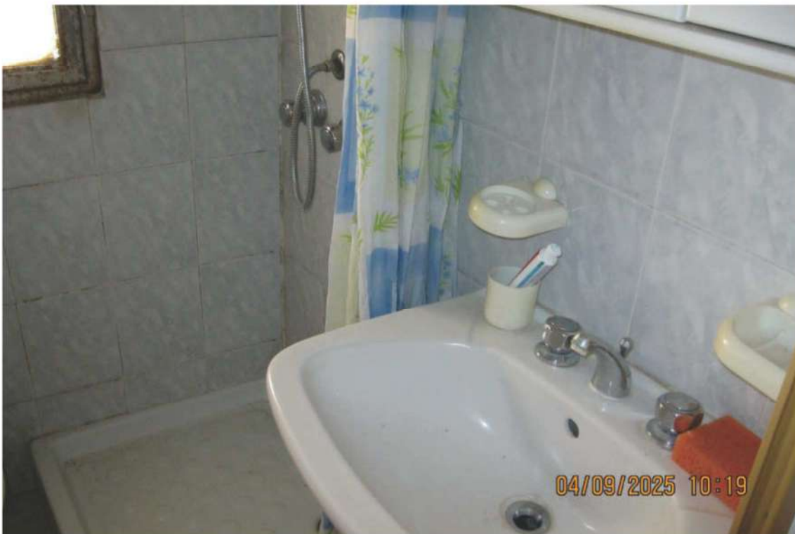
Foto 37: il bagno al secondo piano
