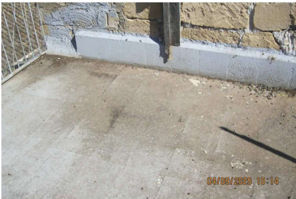
Foto 49: particolare del lastrico solare
