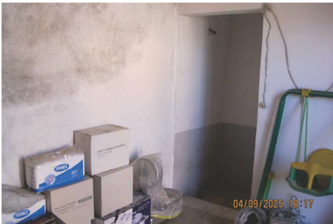
Foto 41: il vano al terzo piano
