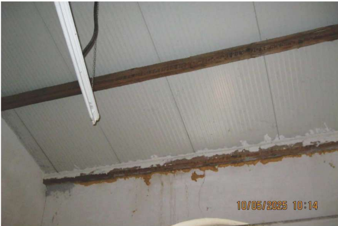
Foto 6: particolare della copertura
