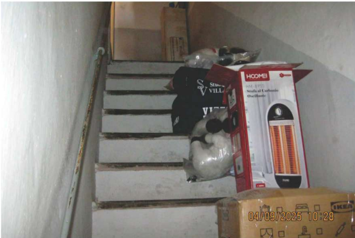
Foto 31: la scala di accesso al secondo piano
