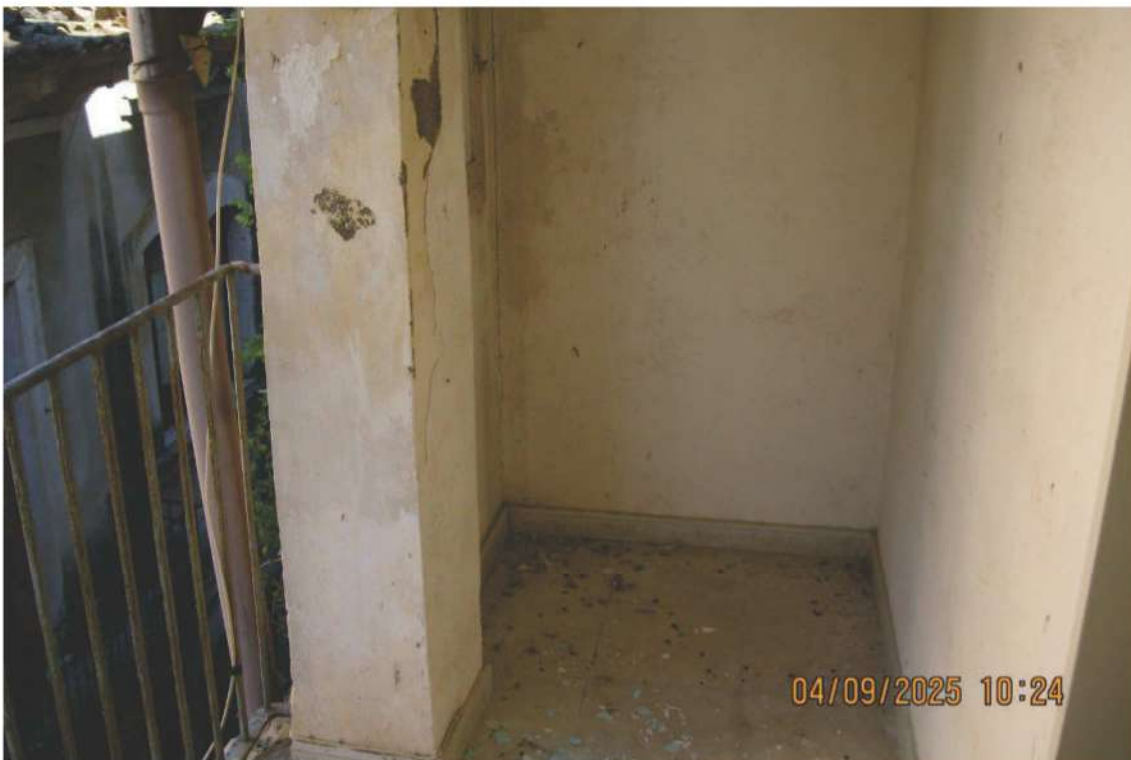
Foto 35: il terrazzino al secondo piano
