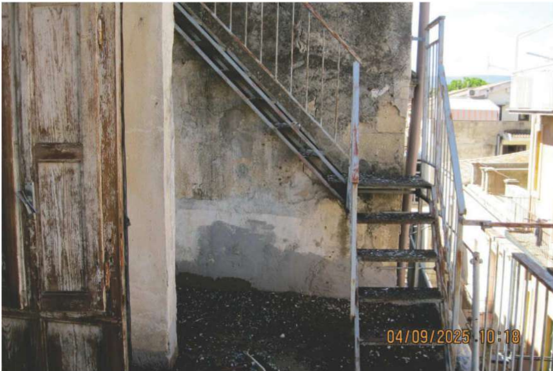
Foto 44: il terrazzino al terzo piano con scala di ferro per accesso al lastrico solare
