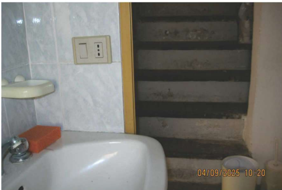
Foto 39: il bagno al secondo piano che affaccia sulla scala di accesso al terzo piano
