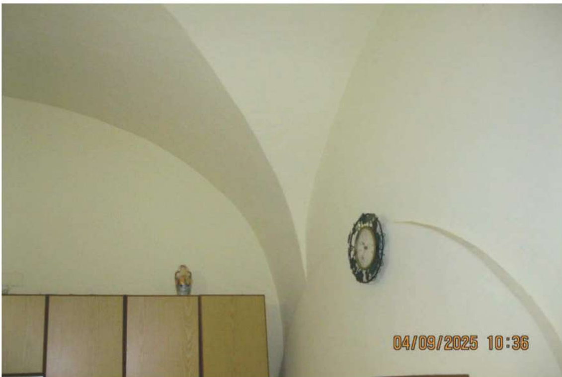
Foto 23: particolare del soffitto
