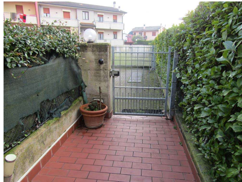
Foto 6: zona di ingresso alla corte ad est (partic. 910 sub 38)
