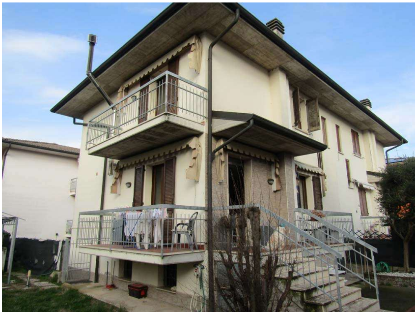
Foto 1: vista d'insieme del fabbricato da sud-est
