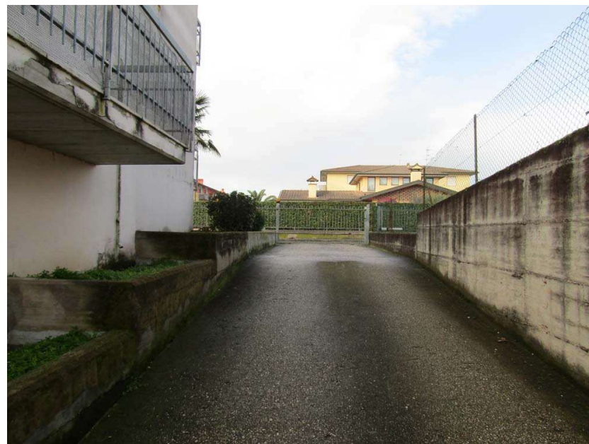
Foto 10: vista della rampa di accesso (partic. 912 sub 12)
