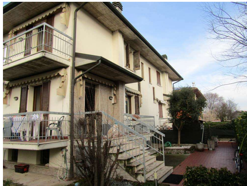
Foto 2: vista d'insieme del prospetto est
