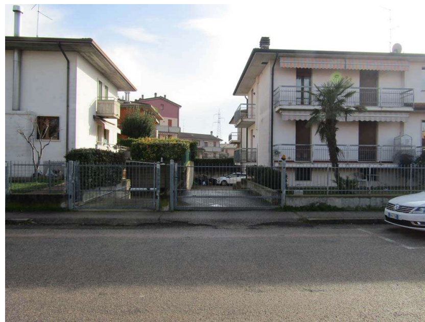
Foto 12: vista dell'accesso carraio da Via Udine 16
