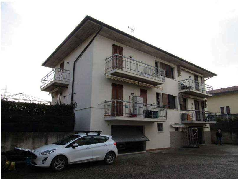
Foto 7: vista dell'edificio dalla corte interna partic. 911 sub 5
