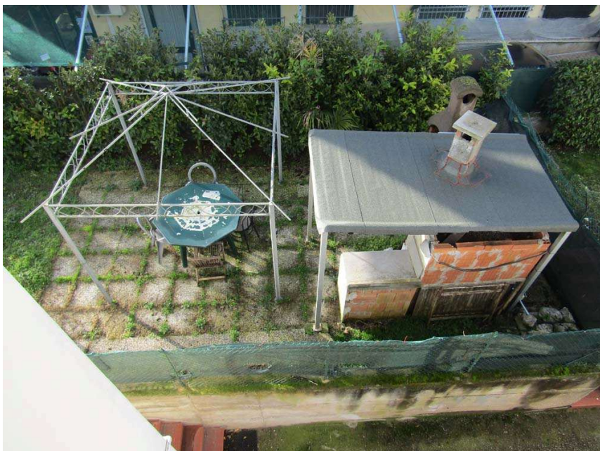
Foto 27: vista dall'alto del camino murario all'interno della corte a sud
