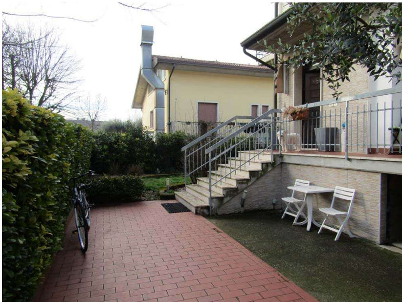
Foto 5: scorcio sulla scala di accesso ad est
