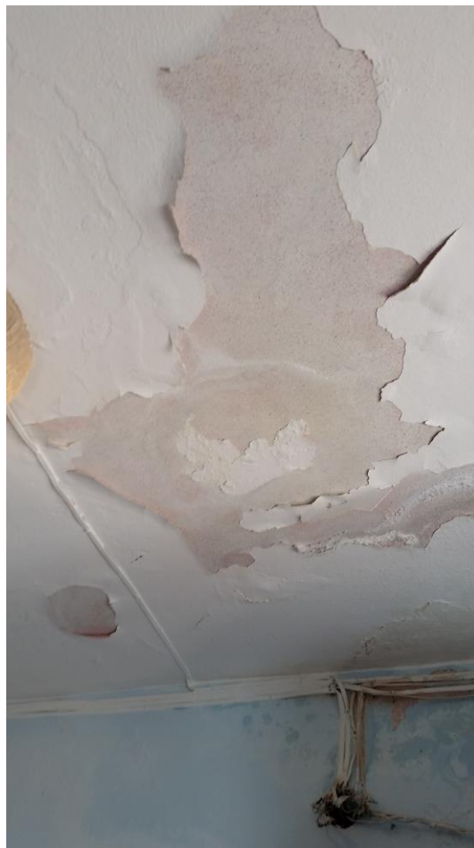
Figura 6-7: Ammaloramenti presenti in corrispondenza dell'intradosso del solaio nel vano d'ingresso dell'immobile de quo
