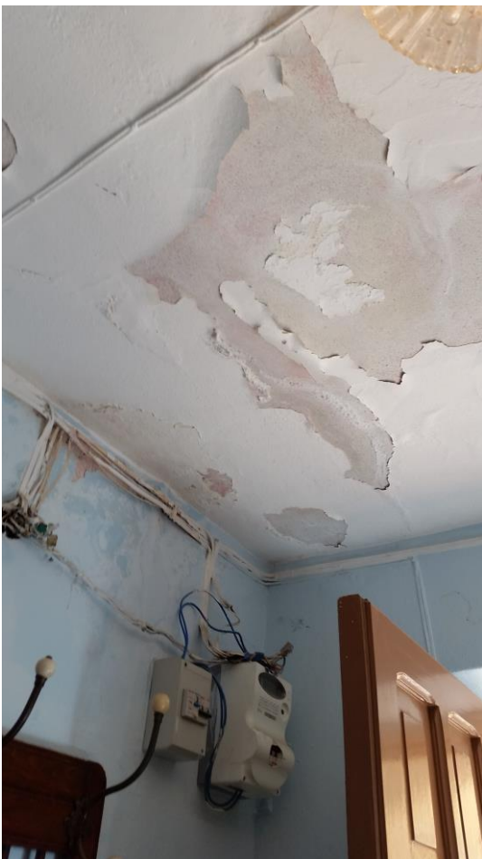
Figura 6-7: Ammaloramenti presenti in corrispondenza dell'intradosso del solaio nel vano d'ingresso dell'immobile de quo
