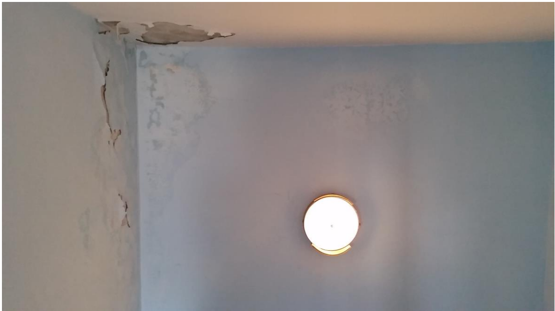
Figura 39: Particolare degli ammaloramenti presenti sull'intonaco delle pareti e dell'intradosso del solaio del vano scala
