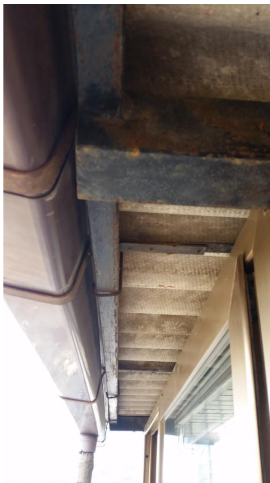
Figura 44: Particolare della copertura
