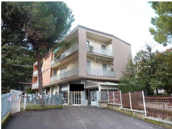
Vista del fabbricato da Via Giovanni Prati
