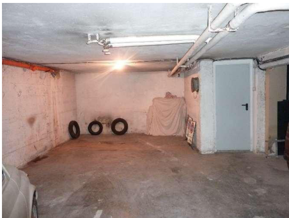
Vista interna autorimessa sub 10
