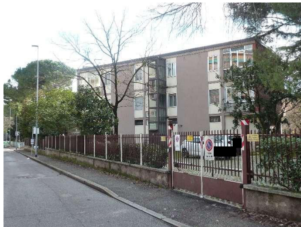
Vista del fabbricato da Via Nicolò Tommaseo
