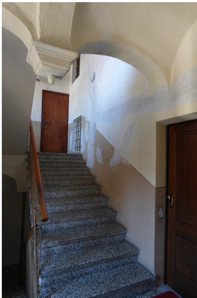
Vano scala comune
