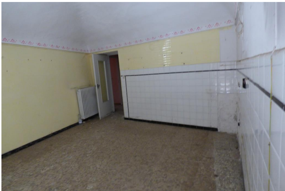
Alloggio al P.1° – SUB. 14
