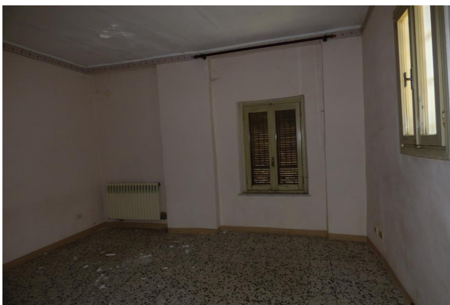
Alloggio al P.2° – SUB. 16
