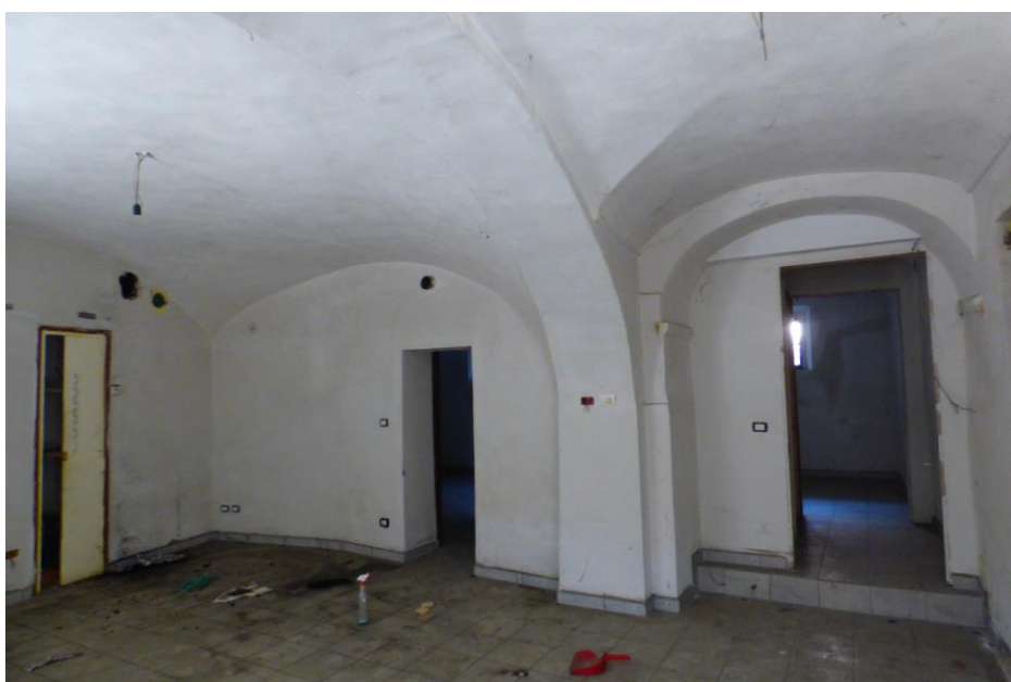
Alloggio al P.T. – SUB. 13
