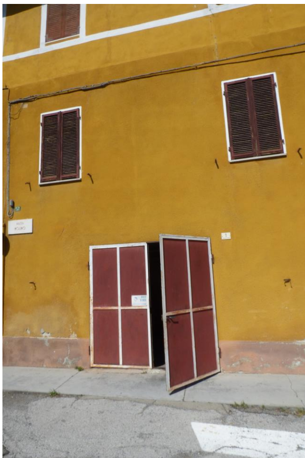
Ingresso Autorimessa SUB. 12
