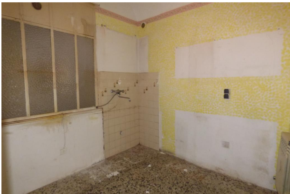
Alloggio al P.2° – SUB. 16
