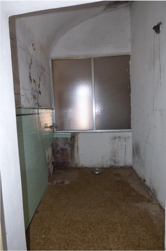
Alloggio al P.2° – SUB. 15
