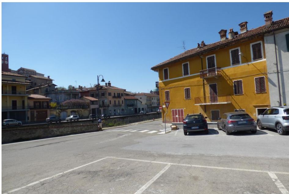
Fabbricato lato P.zza Molino
