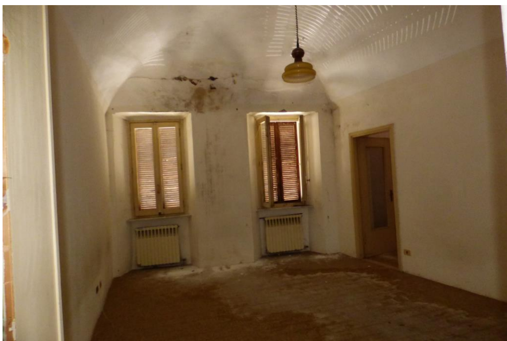
Alloggio al P.2° – SUB. 15
