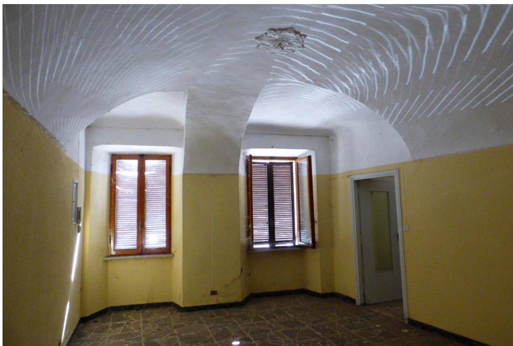
Alloggio al P.1° – SUB. 14
