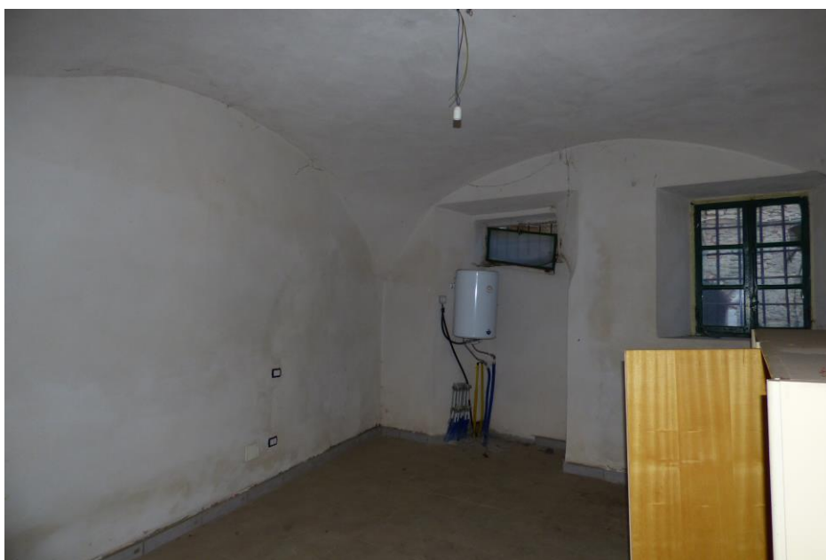
Alloggio al P.T. – SUB. 13
