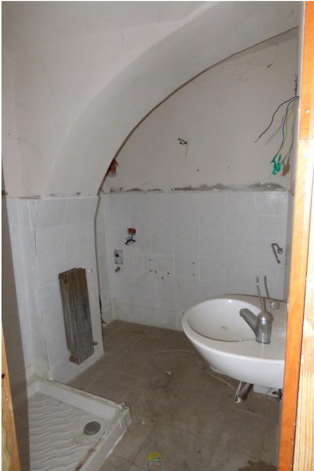
Alloggio al P.T. – SUB. 13
