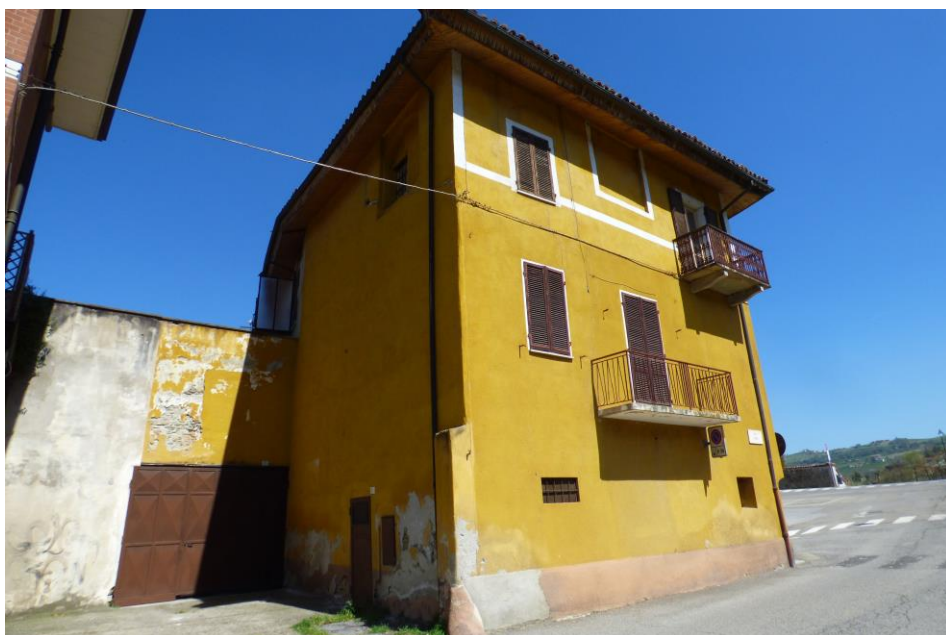
Fabbricato lato Viale Roma e accesso al cortile interno
