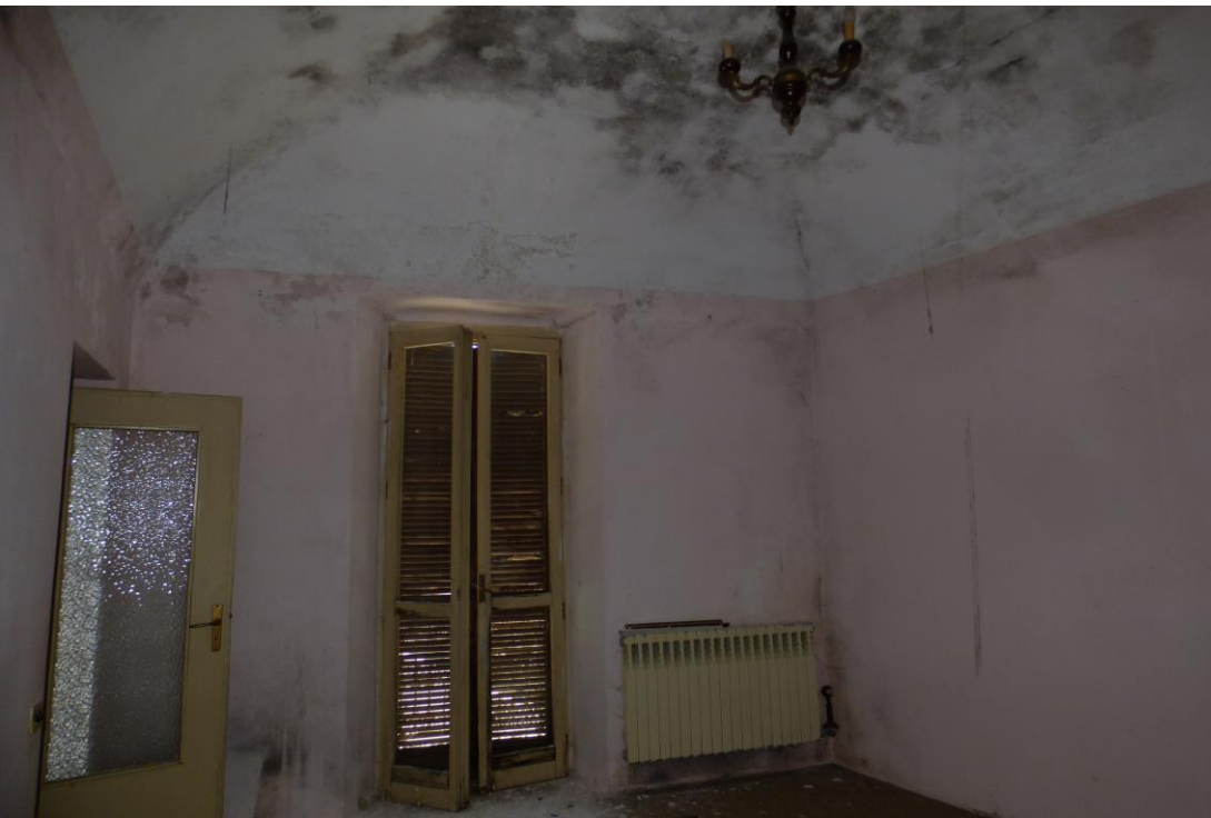
Alloggio al P.2° – SUB. 15
