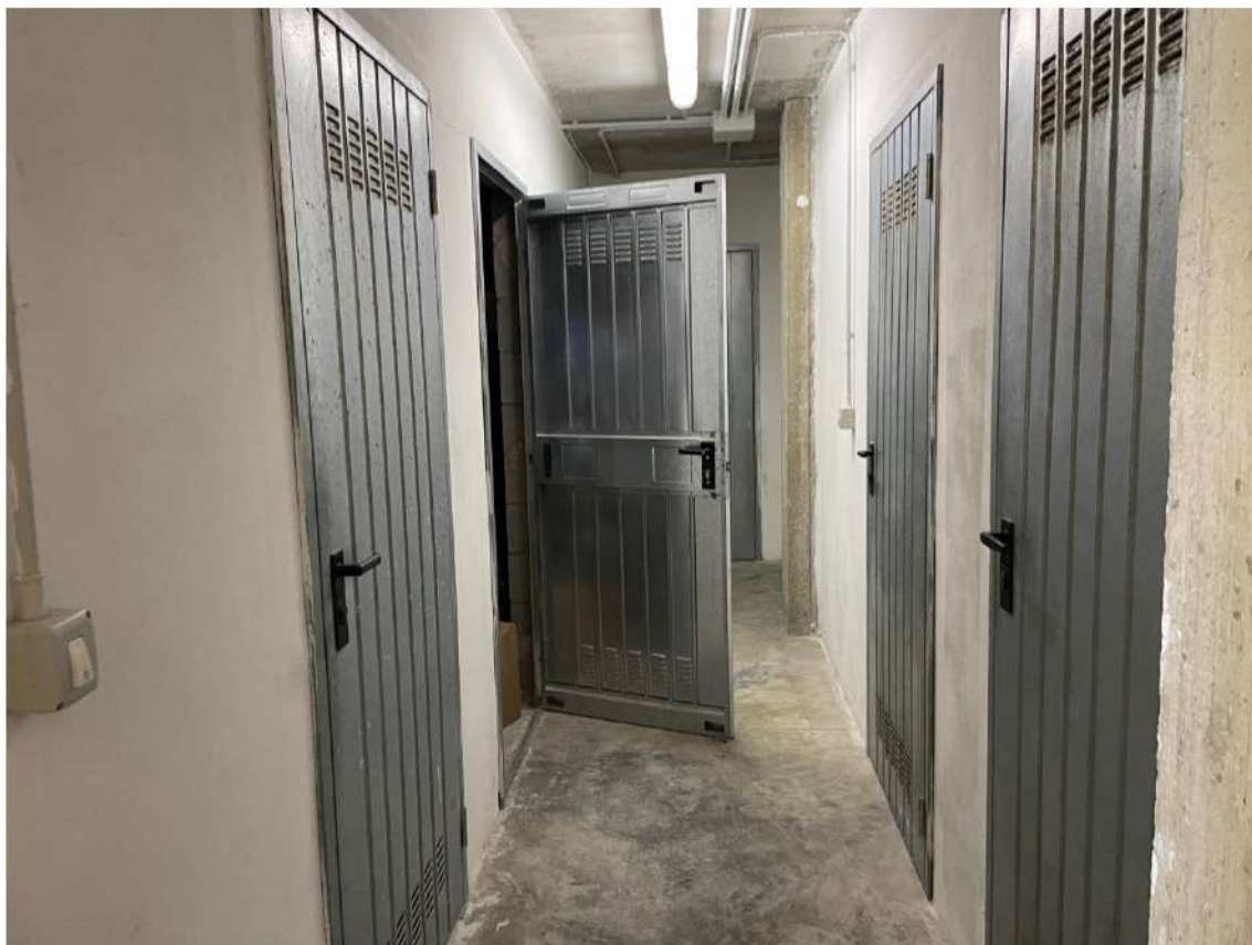
Vista accesso cantina di proprietà piano 1s
