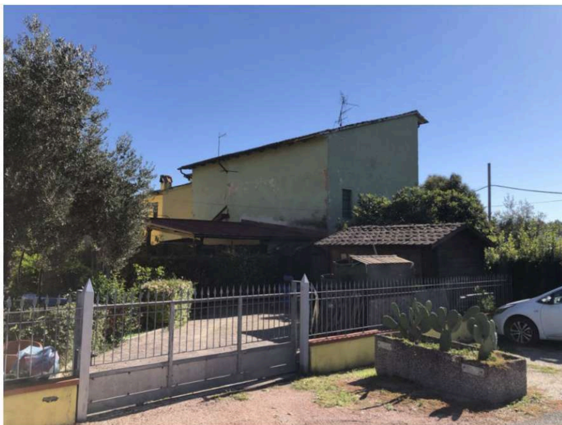
Foto 12 vista esterno – contesto generale e fabbricato lati ovest e nord
