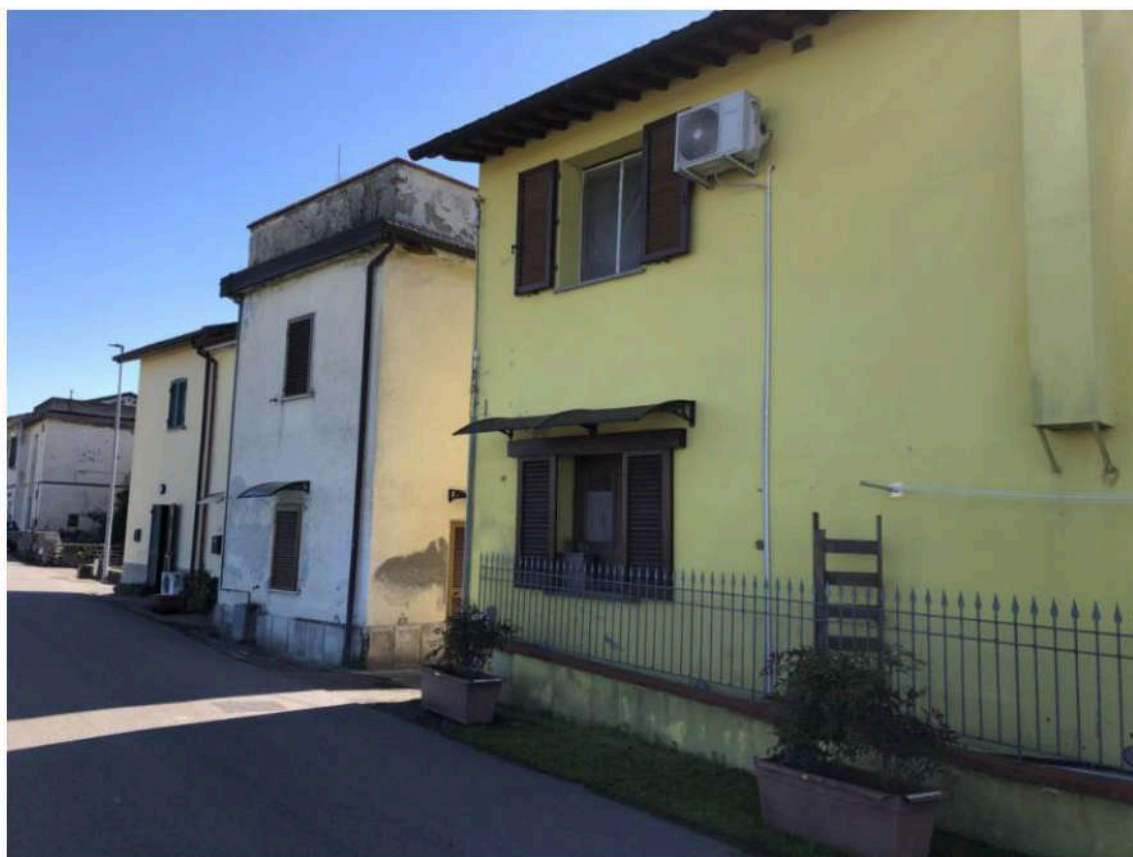
Foto 2 vista esterno – dalla pubblica Via Via Pian del Casone zona accesso
