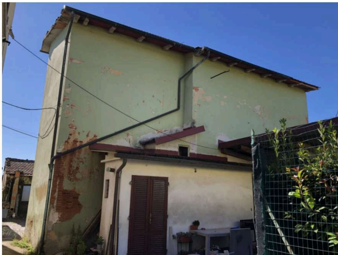
Foto 5 vista esterno – dalla zona accesso lati nord e est del fabbricato
