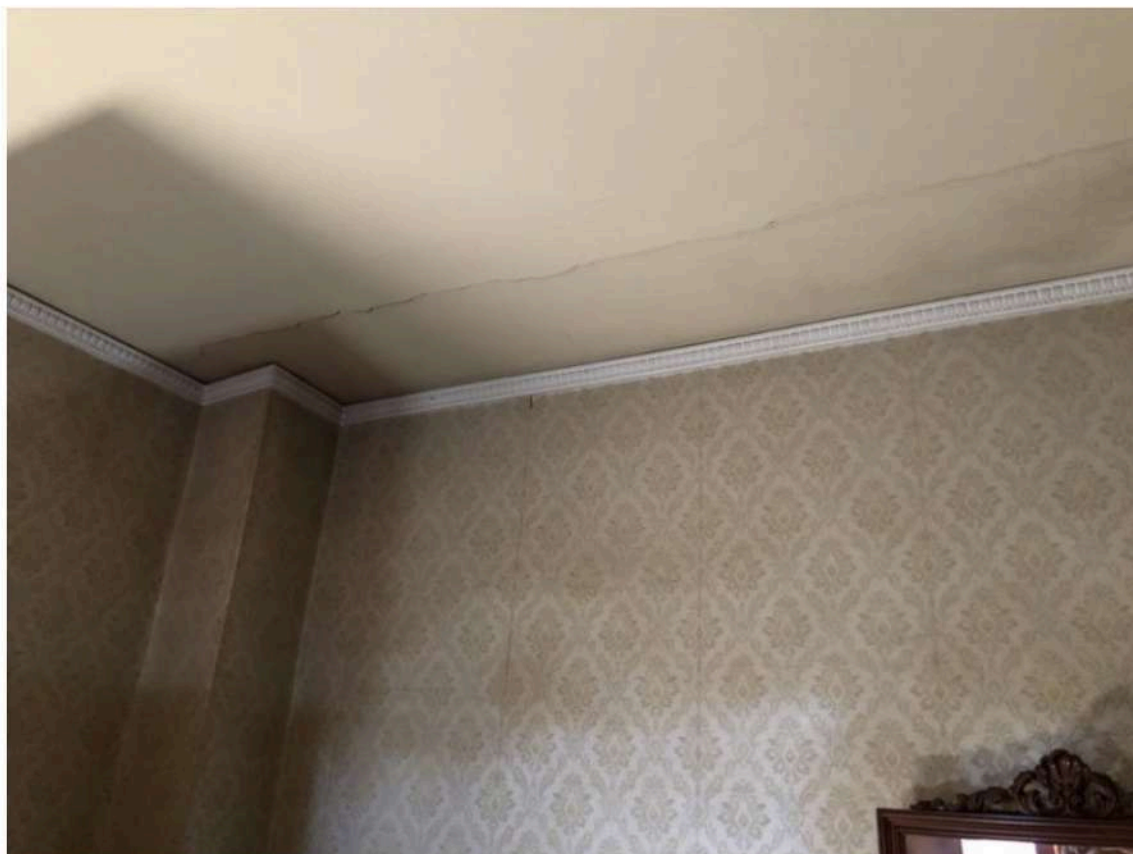
Foto 33 vista interno – prima camera piano primo (particolare soffitto)
