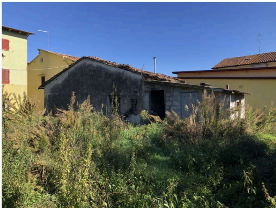
Foto 15 vista esterno – fabbricato accessorio lati ovest e sud dalla corte esclusiva
