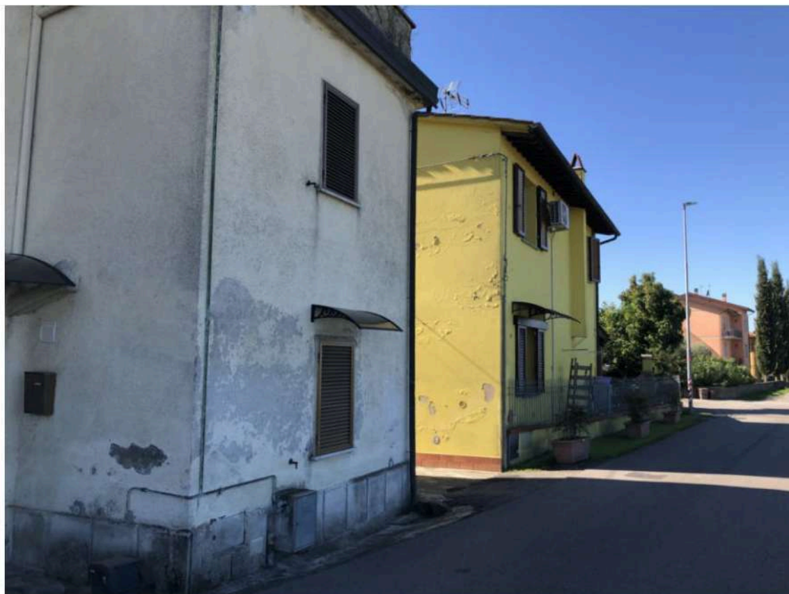
Foto 3 vista esterno - dalla pubblica Via Via Pian del Casone zona accesso
