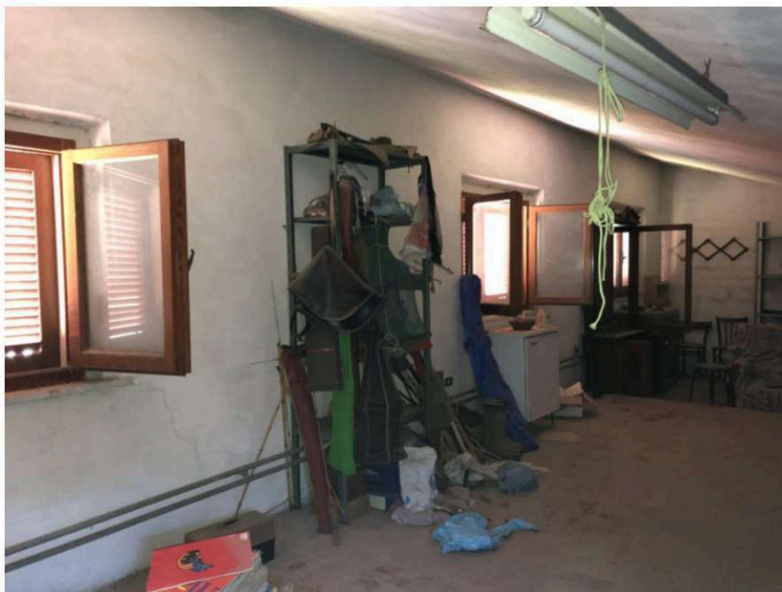
Foto 39 vista interno – soffitta sottotetto
