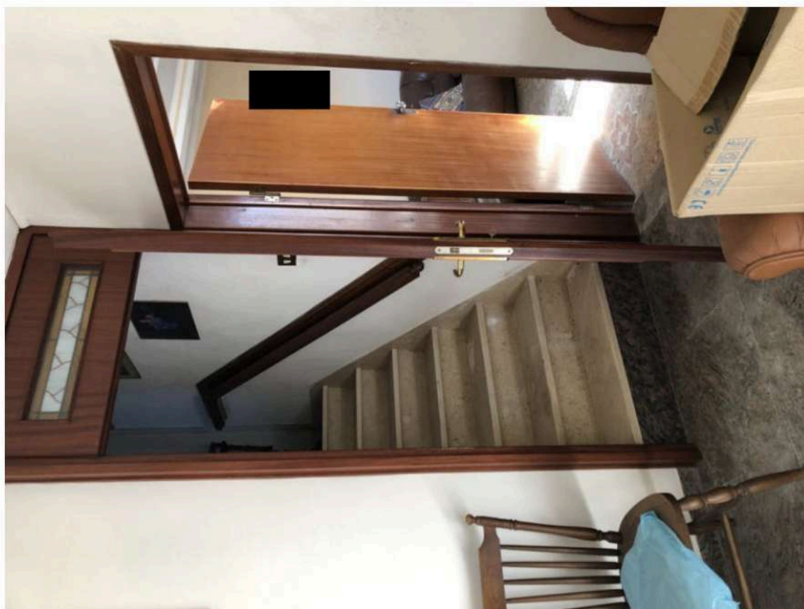
Foto 19 vista interno – ingresso piano terra (vista sulla scala)
