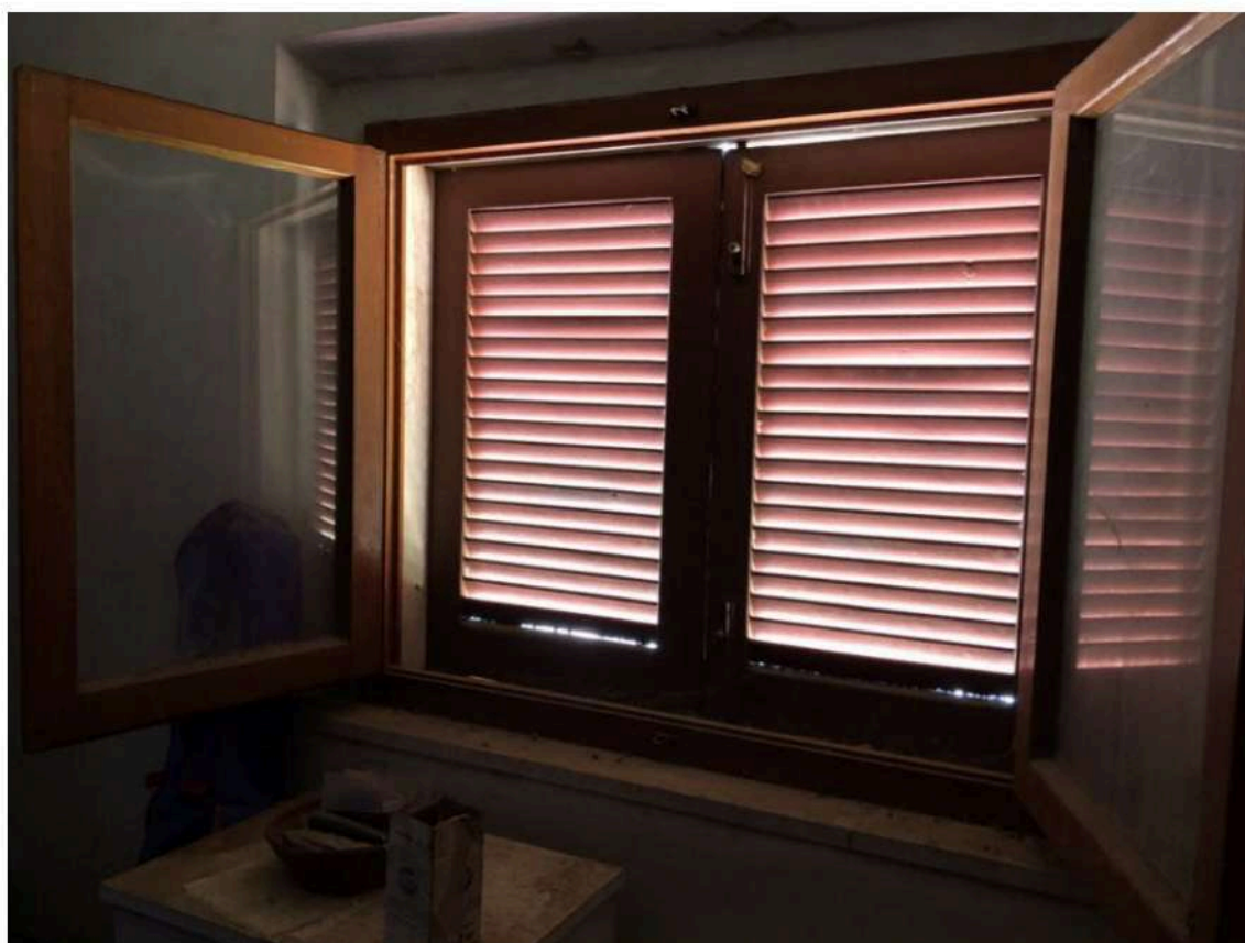
Foto 40 vista interno – soffitta sottotetto (particolare finestra)
