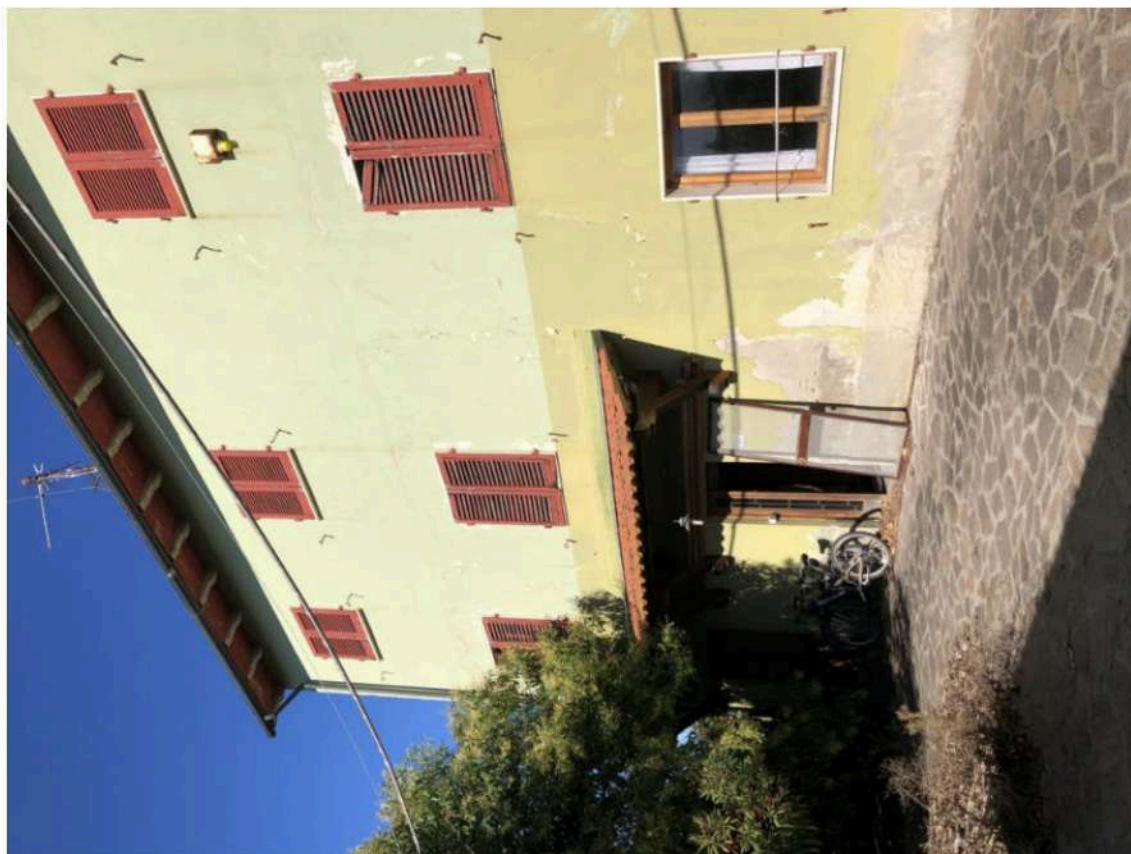
Foto 9 vista esterno – restante porzione lato sud del fabbricato
