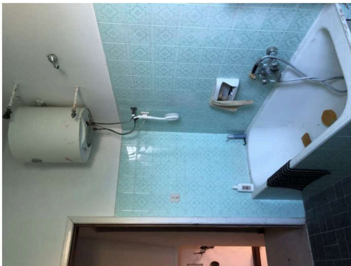
Foto 28 vista interno – bagno piano primo
