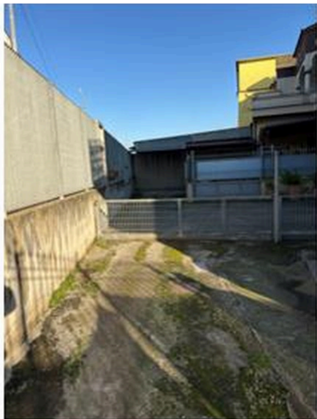
Foto n. 43 - Corte pertinenziale verso il cortile comune sub 101
