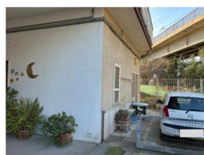
Foto n. 45 - Corte pertinenziale dal cortile comune sub 101
