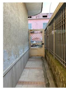
Foto n. 37 - Corte pertinenziale verso via Principe di Piemonte
