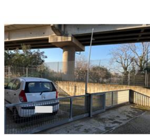
Foto n. 46 - Corte pertinenziale dal cortile comune sub 101
