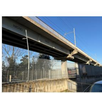
Foto n. 34 - Corte pertinenziale verso la linea ferroviaria
