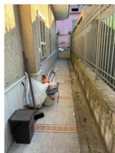
Foto n. 35 - Corte pertinenziale verso via Principe di Piemonte
