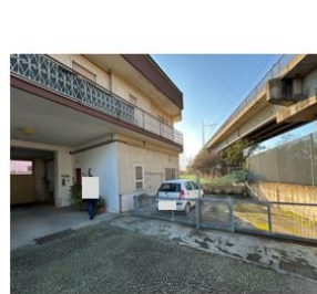
Foto n. 48 - Corte pertinenziale dal cortile comune sub 101
