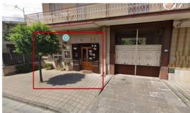
Foto n. 1 – Fabbricato in cui è ubicato l’immobile pignorato
