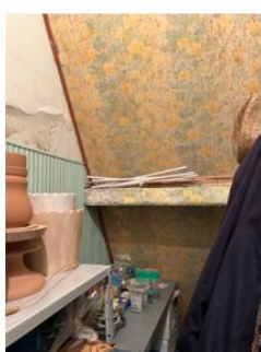
Foto n. 9 - Ripostiglio sotto la scala
